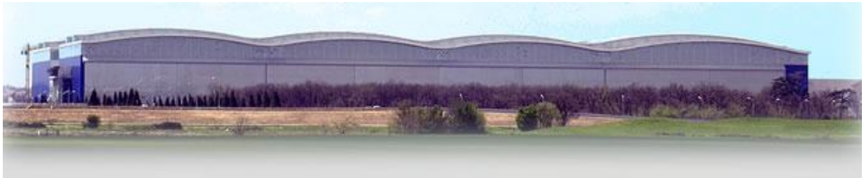
Le hall d'assemblage de l'A 380 (source : grandtoulouse.org)
