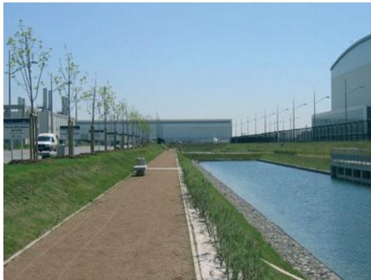
Le bassin de rétention d'AéroConstellation (Source : revue Travaux : 2005)
