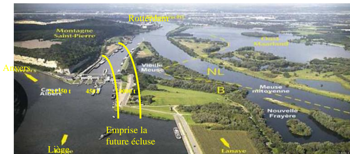
Figure 15. Site des écluses de Lanaye avant les travaux 2011 – 2015 (d'après Henry, 2010)
