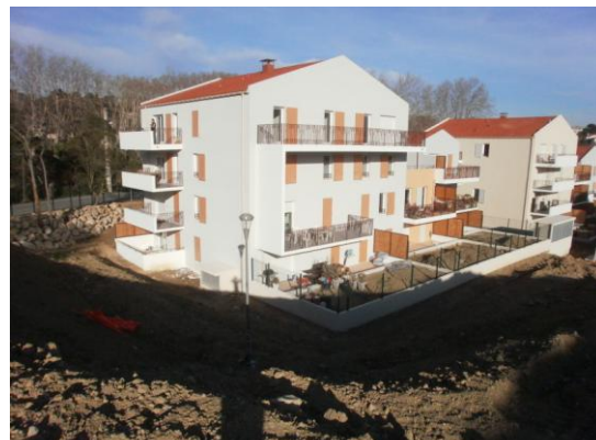
Des ERF encore en construction, projets Collinéo Cap Aldéa, ZAC de Ste Marthe, G. Audren, 2013.
