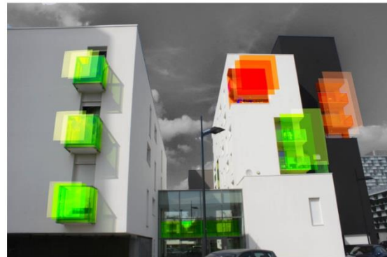
Rue du Cher, logements Chroma: Tres fort appel visuel, effet d'avancée des couleurs, effet de domination visuelle, confort/inconfort visuel, chaleur/froid, effet de masse.
