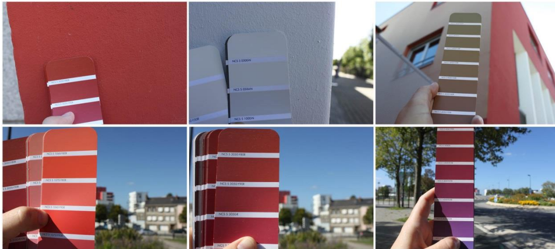
Figure 166, Relevé des teintes du bâtiment le Phare des Alizés (réalisé par l'agence d'architecture Pondevie Unité en 2010) sous le système de notation NCS. En haut à gauche et au milieu : couleurs inhérentes à l'enduit du bâtiment rouge et blanc. En haut à droite, vieillissement et jaunissement de l'enduit rouge en façade Est. En bas à droite, éclaircissement et rosissement des façades ensoleillées perçues à distances. En bas au milieu et à droite, assombrissement et bleuissement des façades à l'ombre perçues à distance. Illustration issue des photos prises sur le terrain d'enquête. Photos : Anne Petit, 2014.
