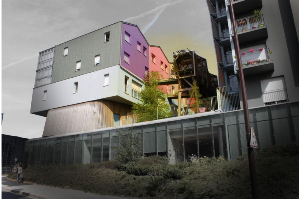
Figure 176, Effet d'appel visuel produit par les couleurs du bâtiment Playtime. Au cœur d'îlot, des teintes roses, violettes, et grenat captent l'attention du passant. La forme architecturale inhabituelle renforce l'effet. La forme des pignons renvoie à l'image pittoresque des maisons colorées de pêcheurs. Cette référence culturelle, ainsi que la présence des couleurs douces, de la végétation et du bois produisent également un effet de chaleur et de confort visuel. Photomontage réalisé d'après les photos des enquêtés et retravaillées sur le logiciel Adobe Photoshop® pour mieux représenter graphiquement les effets ressentis in situ par les enquêtés. Réalisation graphique: Anne Petit, 2014.
