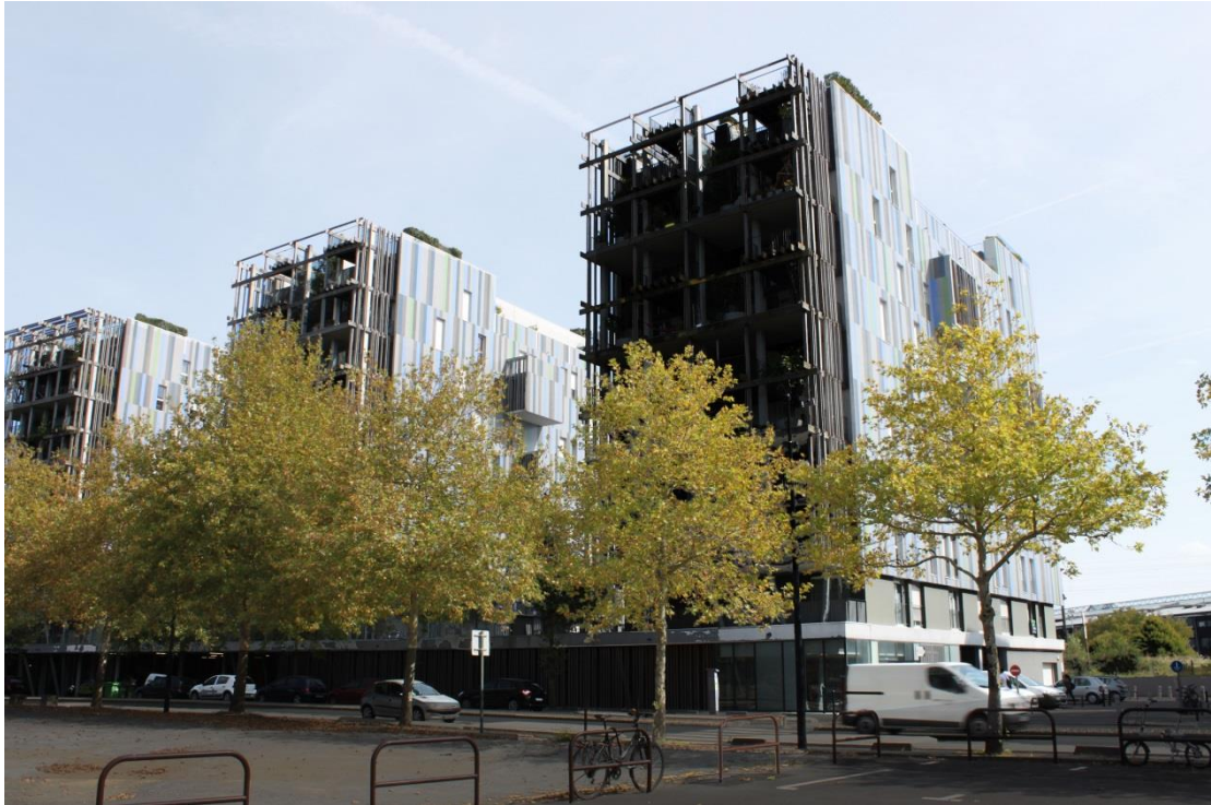
Figure 195, Effet de trou noir en façade des logements Arborea contrasté par un effet de fondu sur les pans latéraux du bâtiment. L'effet de trou noir est ici dû à la profondeur des terrasses en bois et à leur aspect filaire. Photomontage réalisé d'après les photos des enquêtés et retravaillées sur le logiciel Adobe Photoshop® pour mieux représenter graphiquement les effets ressentis in situ par les enquêtés. Réalisation graphique : Anne Petit, 2014.
