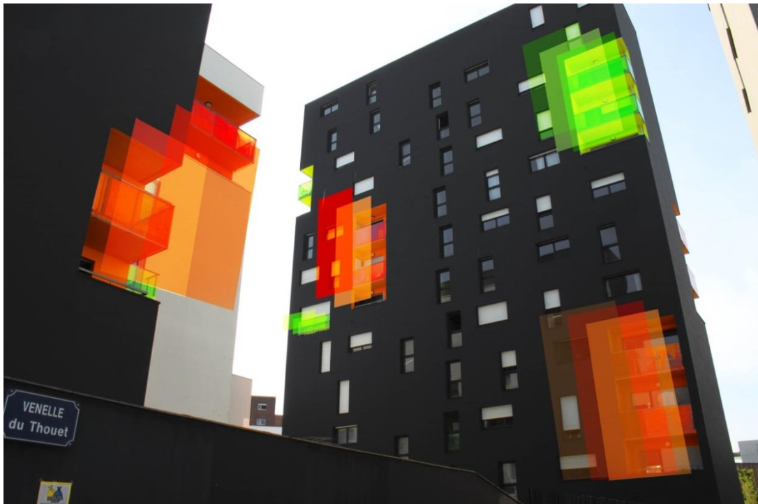
Figure 180, Effet d'avancée des couleurs sur le bâtiment Chroma, l'effet est produit par les balcons et les alcôves vertes et orange en contraste sur une façade gris sombre. Photomontage réalisé d'après les photos des enquêtés et retravaillées sur le logiciel Adobe Photoshop® pour mieux représenter graphiquement les effets ressentis in situ par les enquêtés. Réalisation : Anne Petit, 2014.
