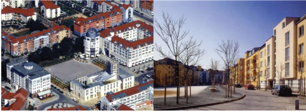
Figure 37, Quartier Kirchsteigfeld, ville de Potsdam en Allemagne. Projet réalisé par Werner Spillmann en 1994. 166
