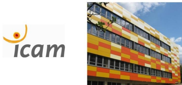
Figure 25, A gauche le logo d'ICAM (Institut catholique des Arts et Métiers), à droite le bâtiment ICAM 110 . Pour la réhabilitation qui prévoyait l'isolation extérieure, les architectes ont souhaité réutiliser les couleurs du logo (rouge, orange, jaune et gris) pour un souci de communication visuelle et pour dynamiser le bâtiment dans son environnement. Photo@ Athena.
