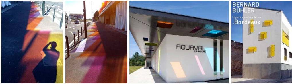
Figure 136, Effet de coulure : à gauche, médiathèque Lisa Bresner, agence d'architecture Rocheteau Saillard, 2013, Nantes 521 . Au centre, piscine Aquaval, agence d'architecture TNA, 2011, Saint-Brieuc 522 . A droite, Logements, Bernard Bühler architecte, Bordeaux. 523
