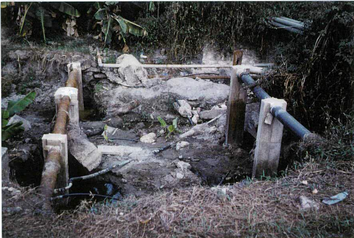
Photo I.6. Des branchements individuels directement sur le réseau primaire
