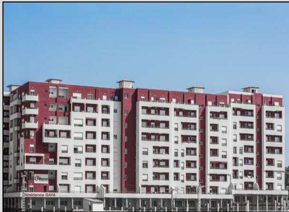
Photo-4- Residence « Gaya », immeuble composé de logements de haut standing et de 3500m 2 de bureaux, livrés en 2012, à Cheraga (Alger) Source : www.bessapromotion.com
