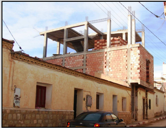
Photos -49- et -50- Dans un quartier proche du Centre-ville, maisons des années 1950 en cours de reconstruction avec poteaux et dalles en béton armé pour remplacer pierres et tuiles Photos Bachar k. 2014
