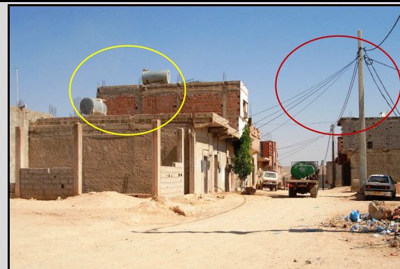
Photo-42- lotissement périphérique : manque d'eau et branchements anarchiques
