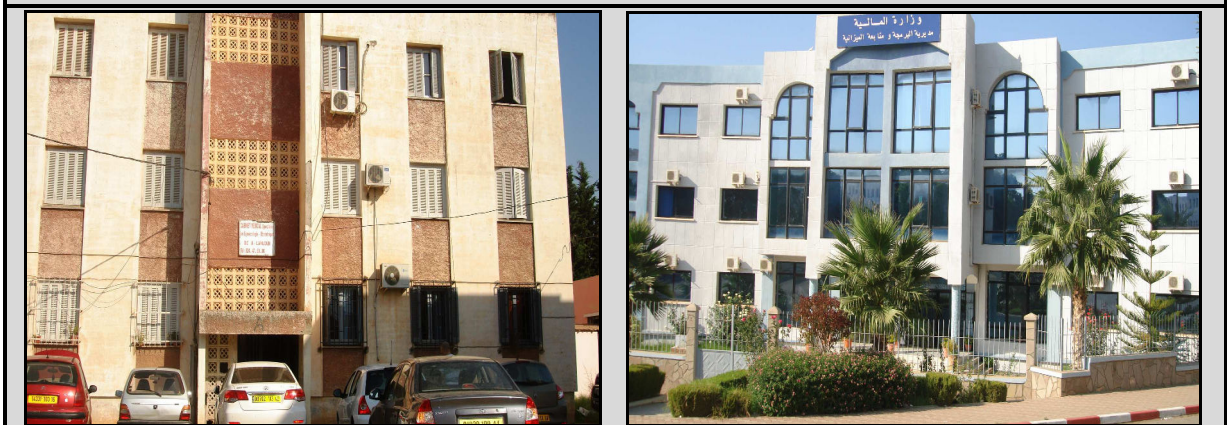
Photos -33- et -34- Malgré le climat clémente de la région, la climatisation électrique se généralise. Les « climatiseurs » sont rajoutés dans les bâtiments anciens comme au niveau de cet immeuble d'habitat, datant du début des années 1980 (à gauche), et font partie intégrante des nouvelles constructions, comme sur cette façade de la nouvelle direction des finances. Photos Bachar k. 2012/ 2013
