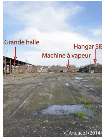
Photo 2 Vue de la plateforme en direction du quartier de la Digue sud. La plateforme, relativement en bon état, est peu colonisée par la végétation, seuls quelques mousses, sédums et herbes basses se développent sur une mince couche de sol qui s'est formée dans des dépressions.
