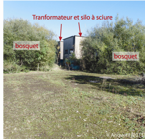
Photo 6 Au premier plan, la plateforme de sciage est recouverte dans sa quasi-totalité par une fine couche de sol constituée d'humus et de poussières, ramenées notamment par les inondations de 1995 et 2001. Du fait de l'abandon plus ancien de cette zone, cette couche de sol est plus épaisse que sur la partie nord de la plateforme centrale (photos 3 et 4). Des bosquets assez denses encadrent le transformateur et l'ancien silo à sciure.
