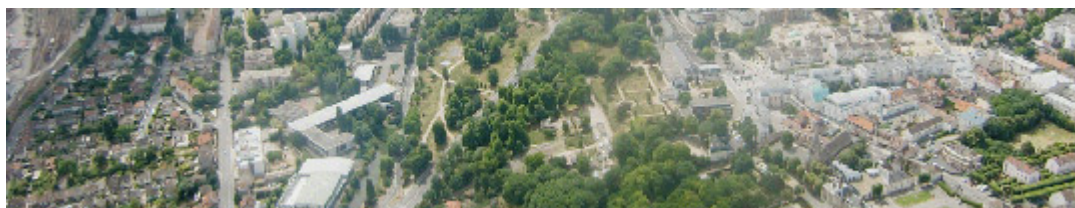
Survol du côteau des Vignes - Urbanité et espace de nature
