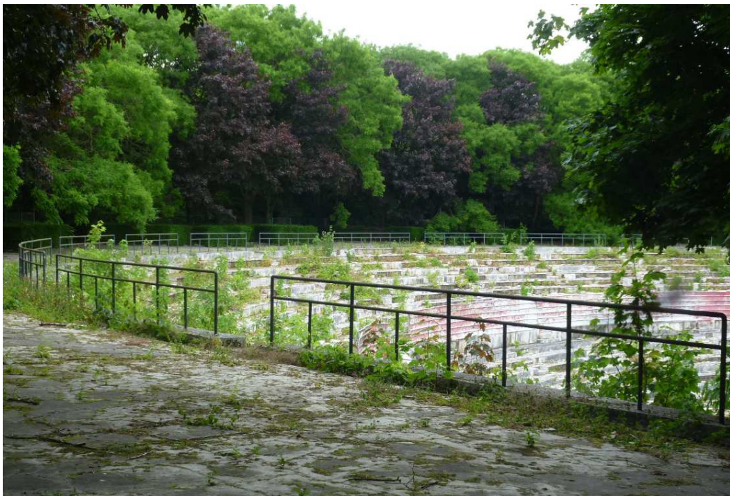
Photo 17. Dans l'enceinte du théâtre fermé par des grilles, de jeunes arbres poussent dans les gradins qui s'affaissent. (juin 2015)
