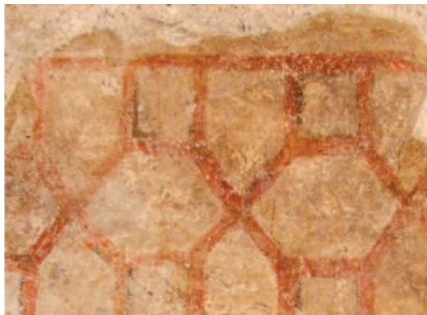
Fig. 55 : Décors géométriques « aux croix de Saint-André » en partie inférieure du mur gouttereau sud. Tour sud ouest. Abbayes Sainte-Marie d'Arles-sur-Tech. Cliché Anne Leturque.
