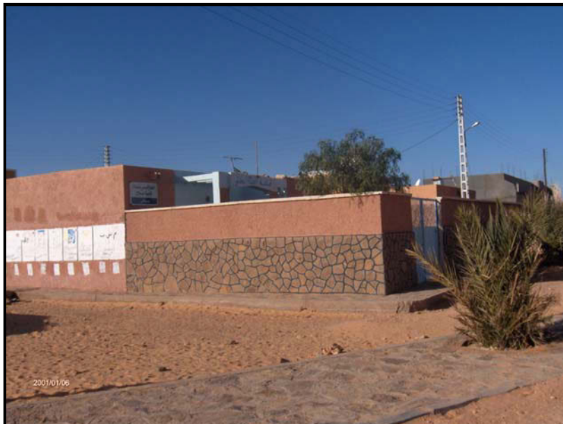
Photo n° 12. Salle de soins dans le ksar de Barrebi à Taghit
