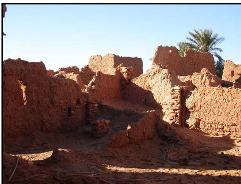
Photo n°56. Ksar de Kenadsa en ruine
