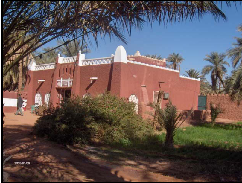
Photo n° 52. Nouvelle résidence construite dans les jardins de l'oasis de Timimoun (propriétaire d'Alger)
