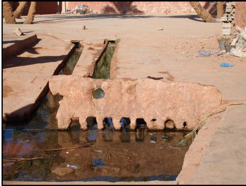
Photo n° 6. Foggara, mal entretenue dans l'oasis de Timimoun
