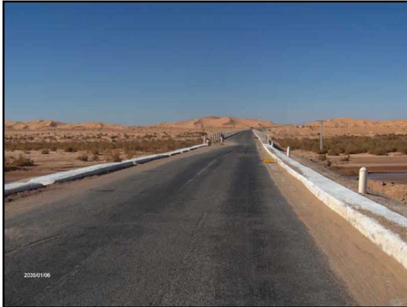
Photo n° 24. La Route Nationale RN6 (tronçon Bechar –Adrar) : Bon état général
