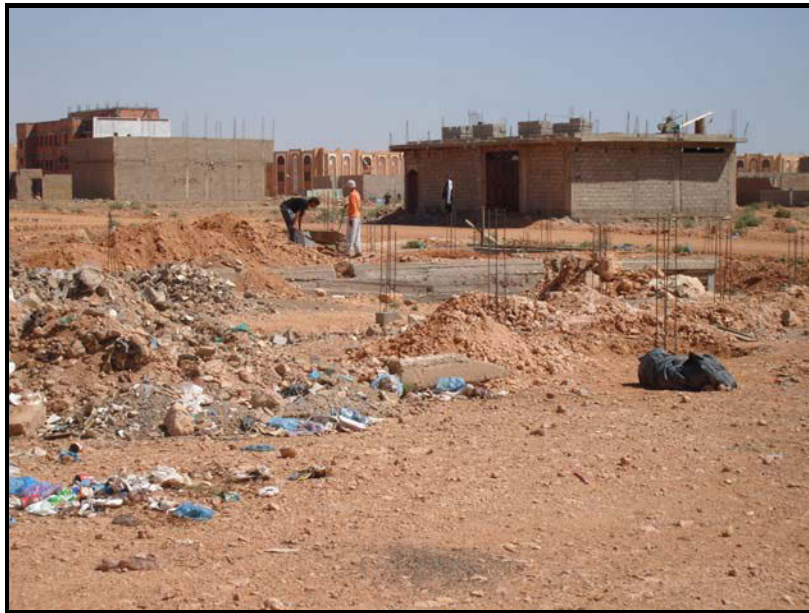
Photo n° 48. Lotissement dont les constructions sont lentes et inachevées à Bechar
