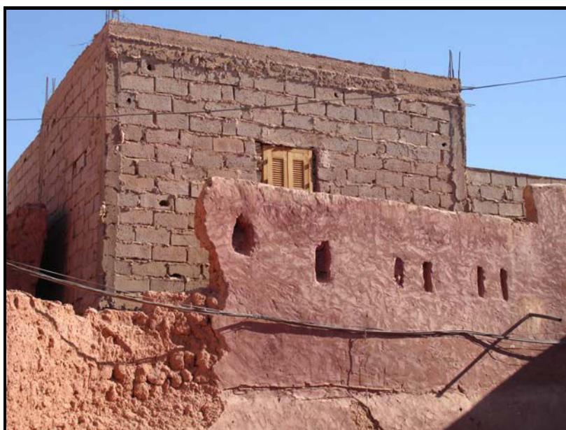
Photo n°57. Mutation de l'habitat au sein du Ksar (Timimoun)
