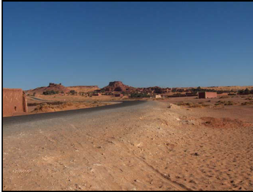
Photo n° 25. Route de wilaya (Timimoun-Ouled Saïd): Bon état général
