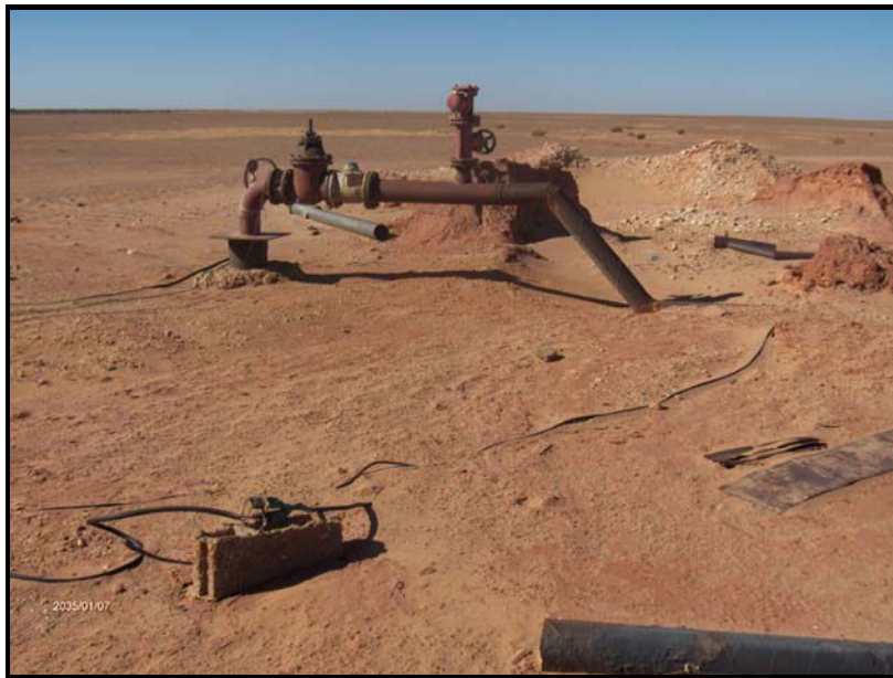
Photo n° 8. Forage d'une mise en valeur à Aourout (wilaya d'Adrar)
