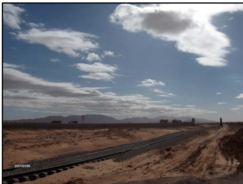
Photo n° 23. La nouvelle ligne de chemin de fer Oran-Bechar
