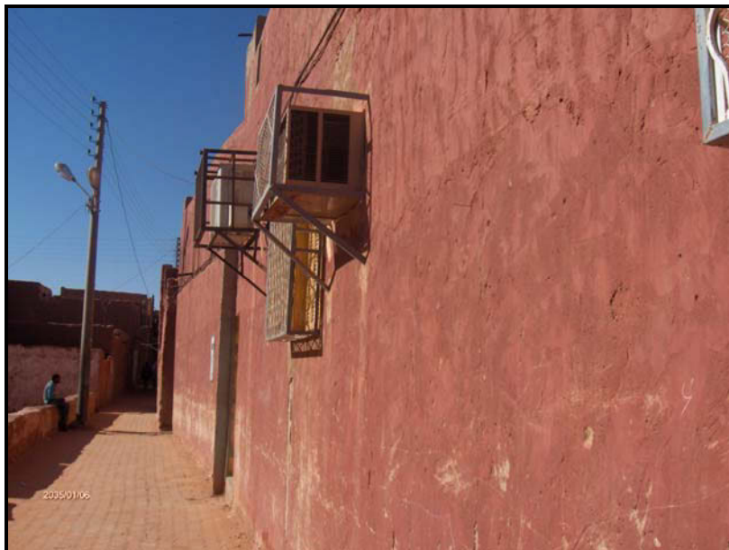
Photo n°61. L'électrification des ksour : vulgarisation de l'utilisation des climatiseurs (ksar de Timimoun)
