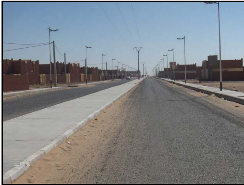
Photo n°51. Nouvelles extensions de la ville d'Adrar (logements LSP à Tililane)
