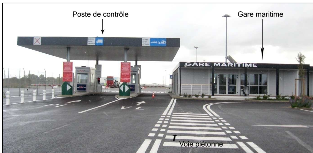
Figure 48 : Gare maritime et poste de contrôle
