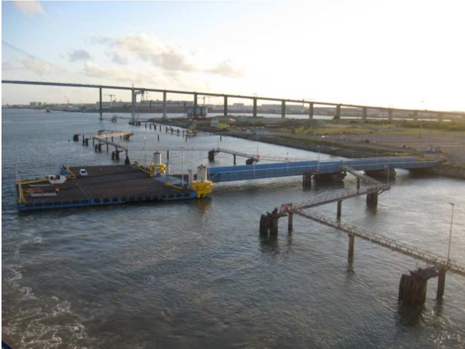
Poste du terminal roulier
