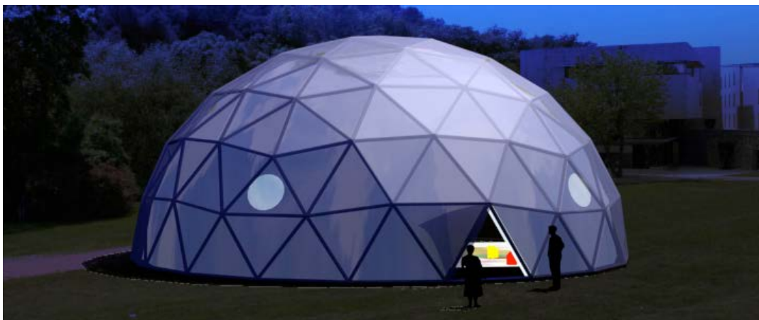
Figure 29 : Représentation graphique de la structure géodésique
