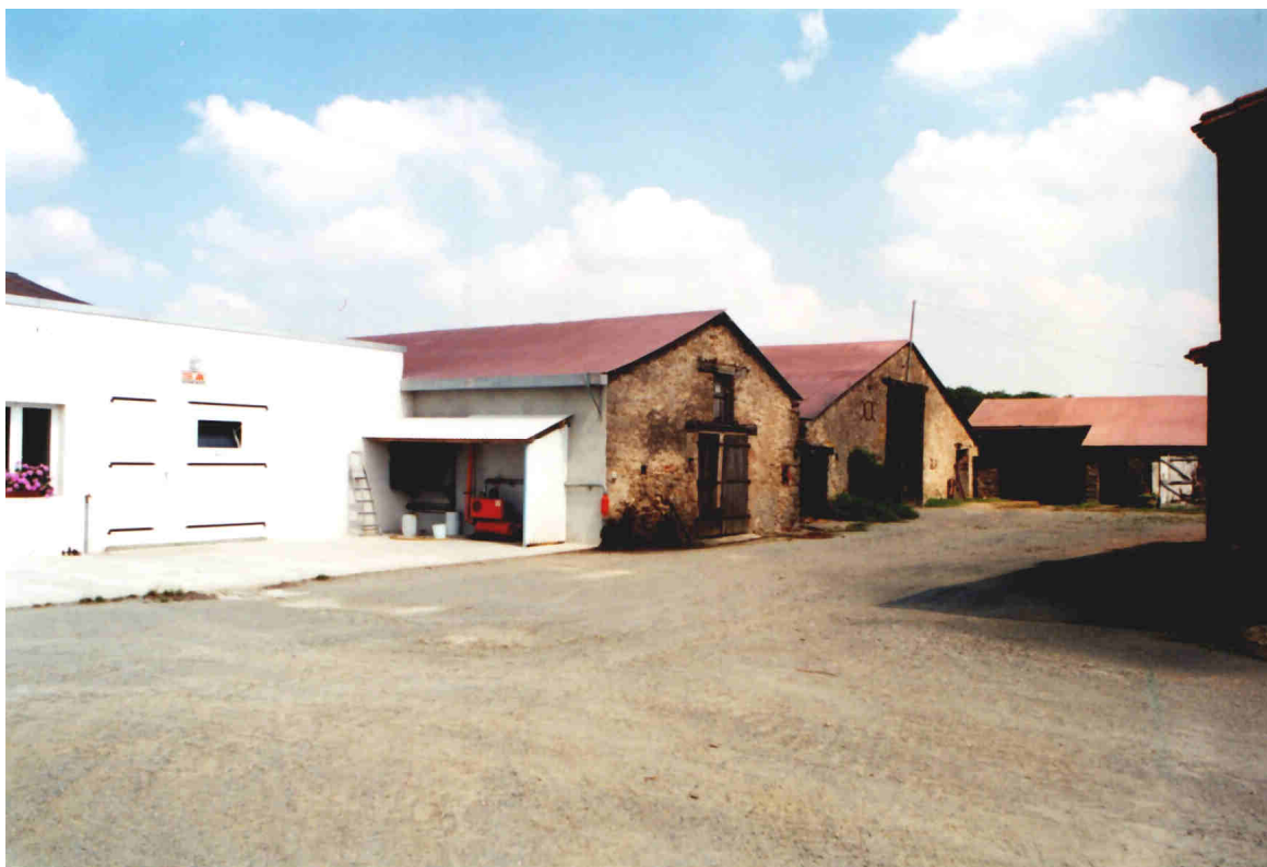
Illustr. 30 - La Denisière : la nouvelle salle de traite et les anciennes étables
