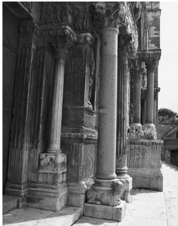
Abb. 99 Sockelbereich der Westfassade Nordportal 259
