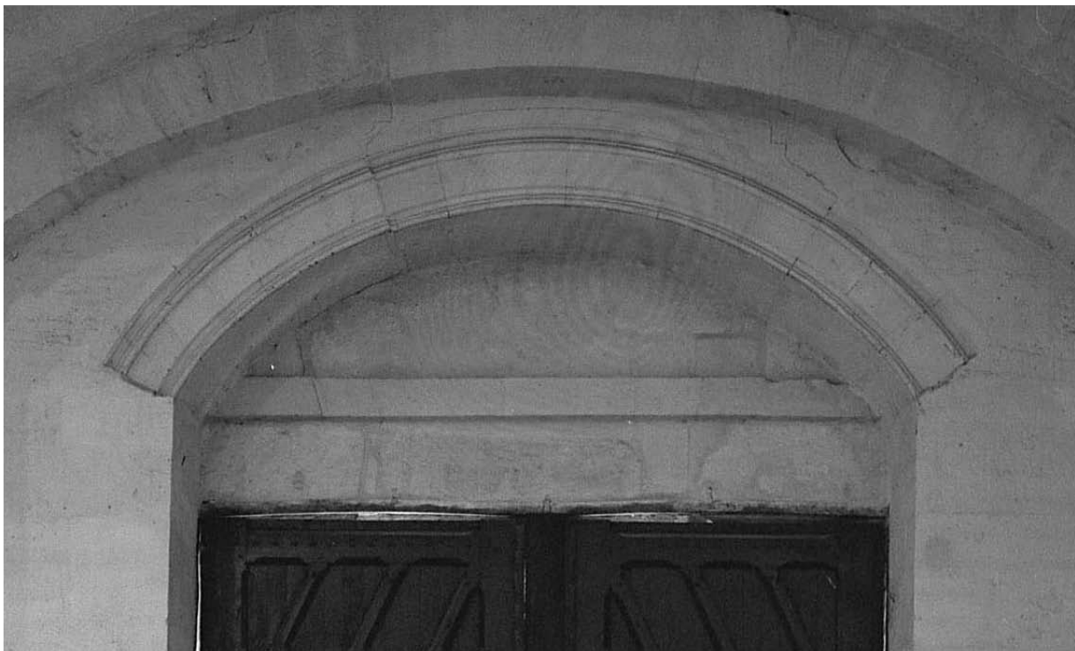
Abb. 111 Entlastungsbogen für den Sturz im Hauptportal
