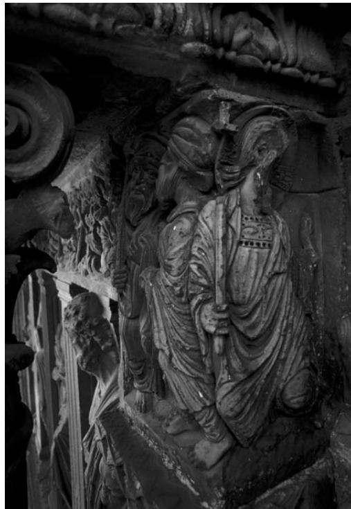
Abb. 103 Passionsfries nördlich des Südportals - Abarbeitungen zur Verringerung der Blockhöhe und schlechte Übergänge zu benachbarten Blöcken
