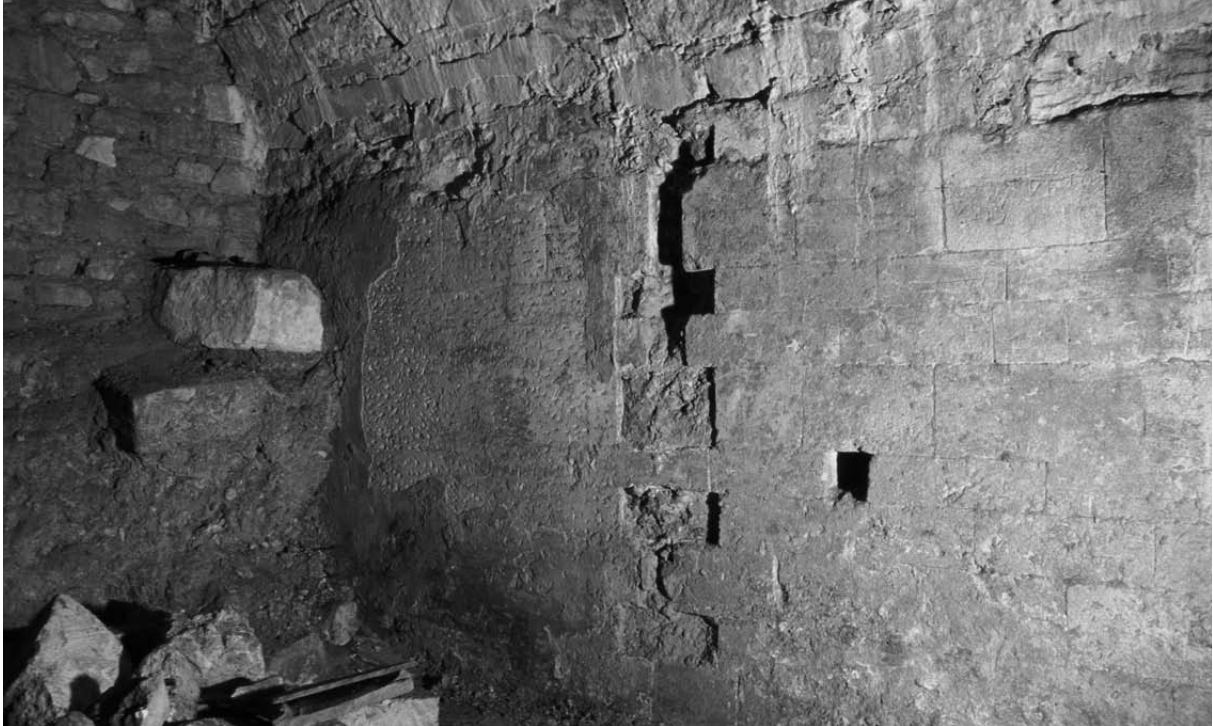
Abb. 84 Raum unter der Treppe Tonnenfundament, Anschluss an die südliche Stirnwand
