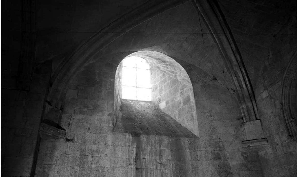
Abb. 94 Westliches Joch der Südwand Zweite, nachträgliche Fensterphase
