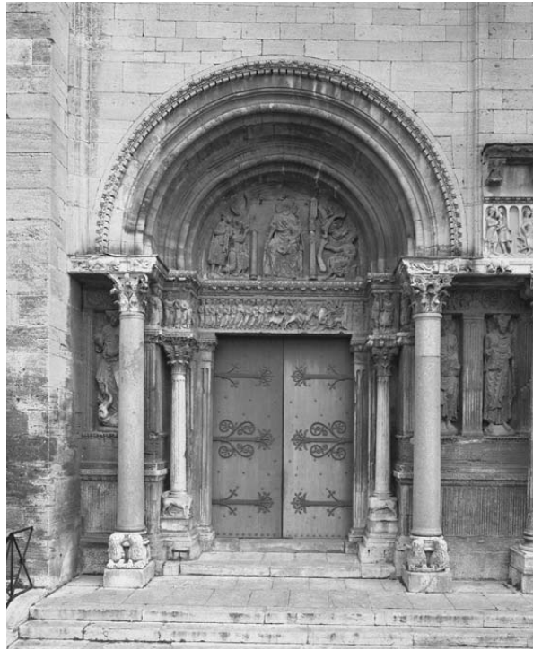
Abb. 56 Nordportal der Westfassade (A. Schlamann)
