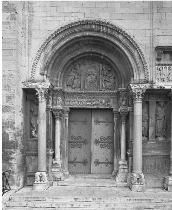
Abb. 56 Nordportal der Westfassade (A. Schlamann)
