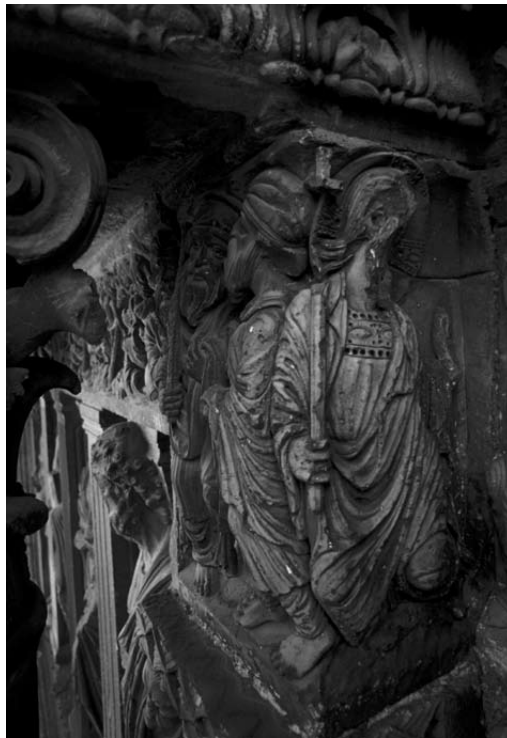
Abb. 103 Passionsfries nördlich des Südportals - Abarbeitungen zur Verringerung der Blockhöhe und schlechte Übergänge zu benachbarten Blöcken
