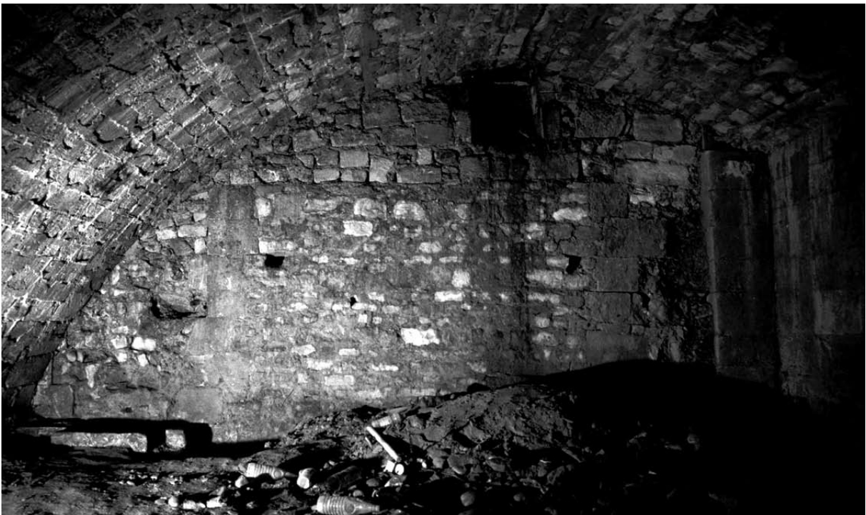
Abb. 85 Raum unter der Treppe Nördliche Stirnwand 252
