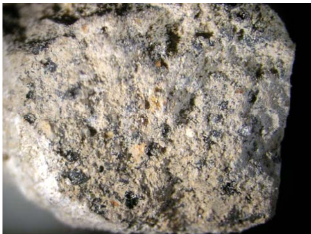
Abb. 1498.Probe 03.1: Probe 03 entspricht Probe 16; graubrauner Mörtel mit Schlacke- und Ziegelzusatz (Restaurierungsmörtel).
