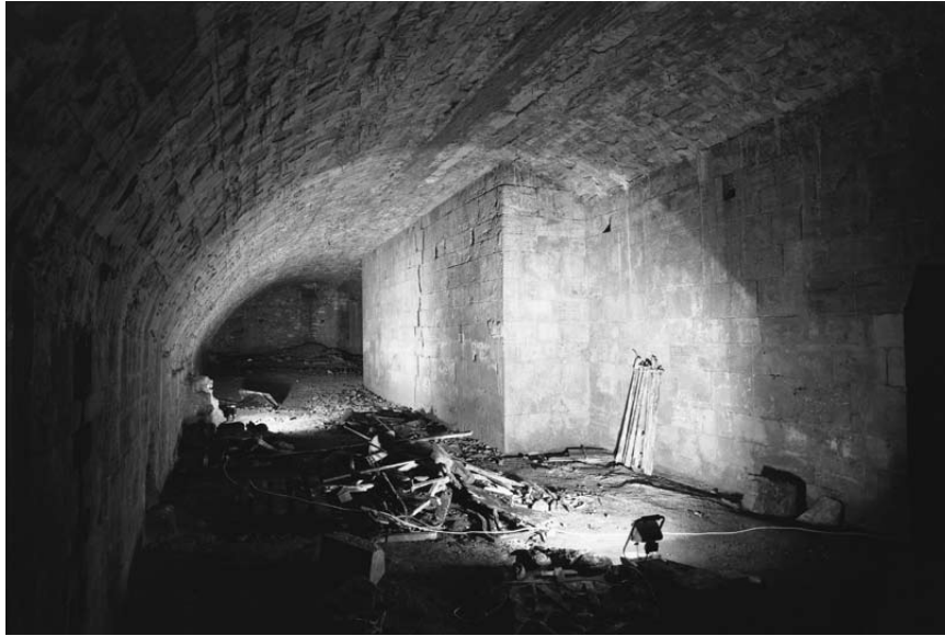
Abb. 69 Raum unter der Treppe - Blickrichtung nach Norden auf den Mittelrisalit (A. Schlamann)
