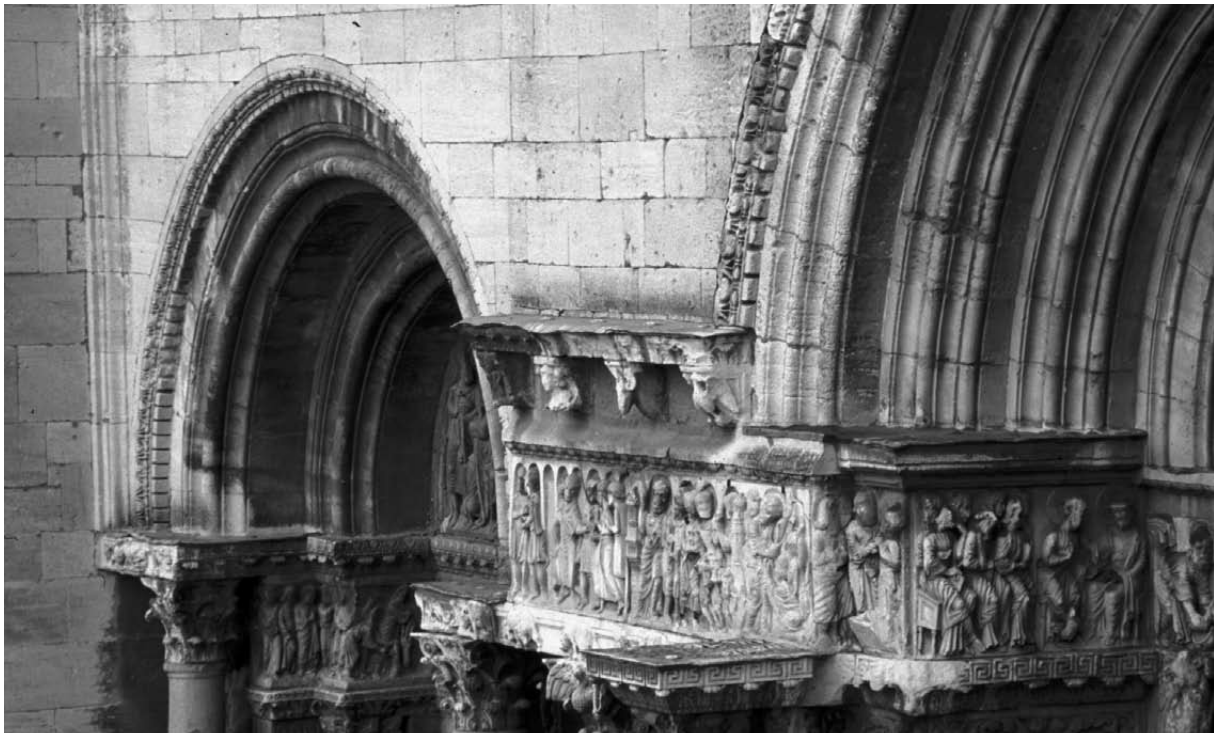
Abb. 109 Auflager der Archivolten Nördliches Seitenportal und Hauptportal im Vergleich 264
