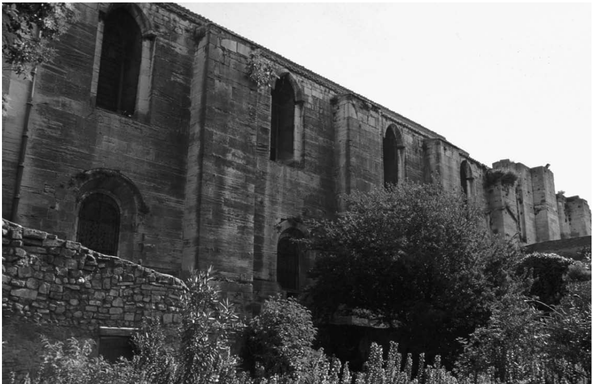
Abb. 95 Südwand der ehemaligen Abteikirche Nachträglich eingebaute Fensteröffnungen in Joch I und II von Westen
