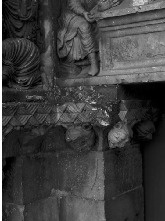
Abb. 102 Südportal - Auflager des Türsturzes Passstücke zum Ausgleich unterschiedlicher Bauhöhen
