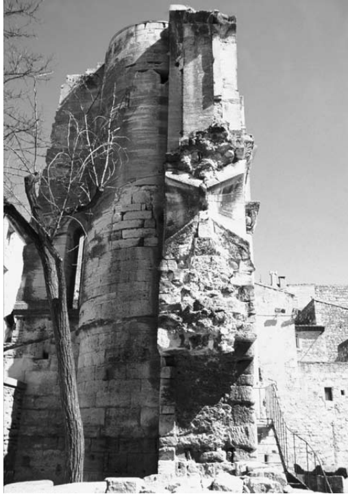
Abb. 122 Chorruinen der ehemaligen Abteikirche Saint-Gilles Blick in das Innere der Außenmauern
