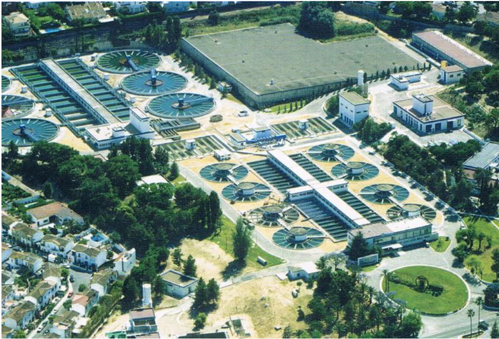
Photo 14 : L'usine de potabilisation du Carambolo vue du ciel
