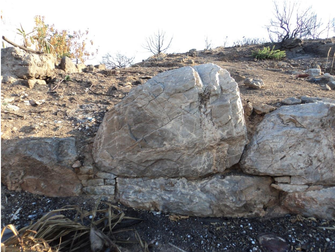
Figure 103 – Atene TH01 : détail du mur S-O de la tour (photo P. Roux, Oct. 2012)
