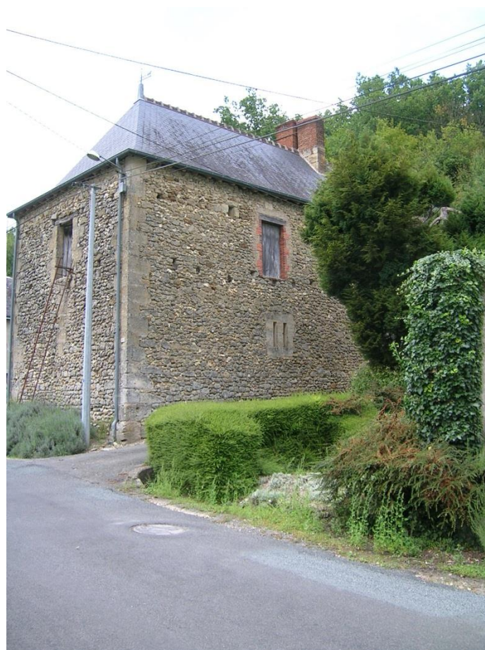
Figure 122 - Villaines-les-Rochers (37) Grange et regards pour le vannage (Photo P. Roux, Sept. 2008)
