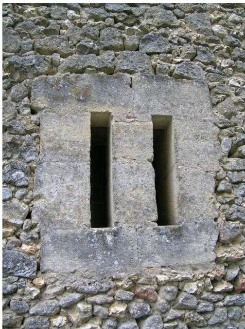
Figure 123 - Villaines-les-Rochers (37) Regards pour le vannage dans le mur opposé à la porte de la grange (Photo P. Roux, Sept. 2008)
