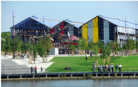
Esplanade des chantiers
