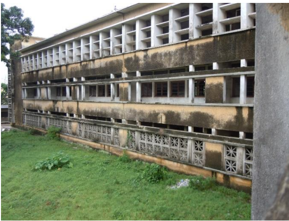
Lycée Savorgnan de Brazza , façades extérieure et intérieure, Brazzaville (Cliché pris en février 2016)
