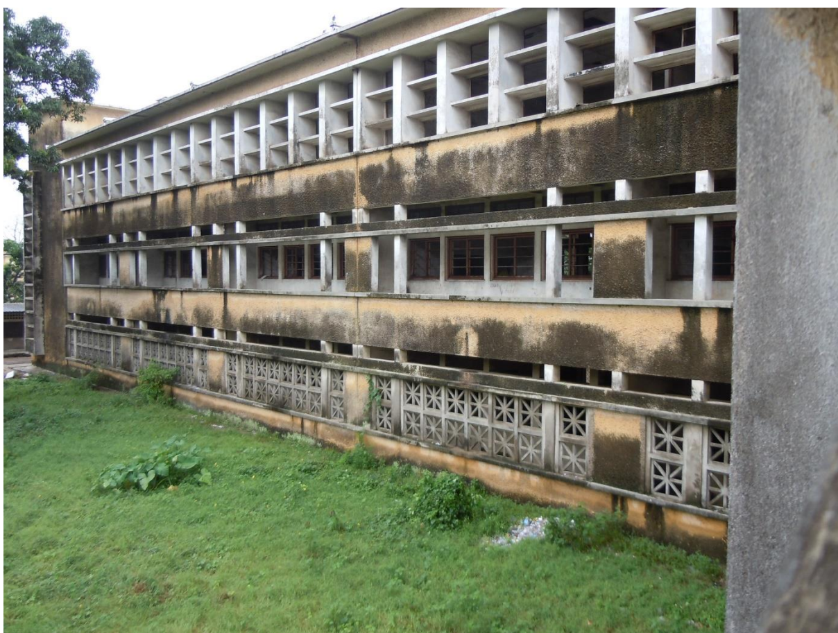
Lycée Savorgnan de Brazza, façade intérieure (Cliché pris à Brazzaville en février 2016)
