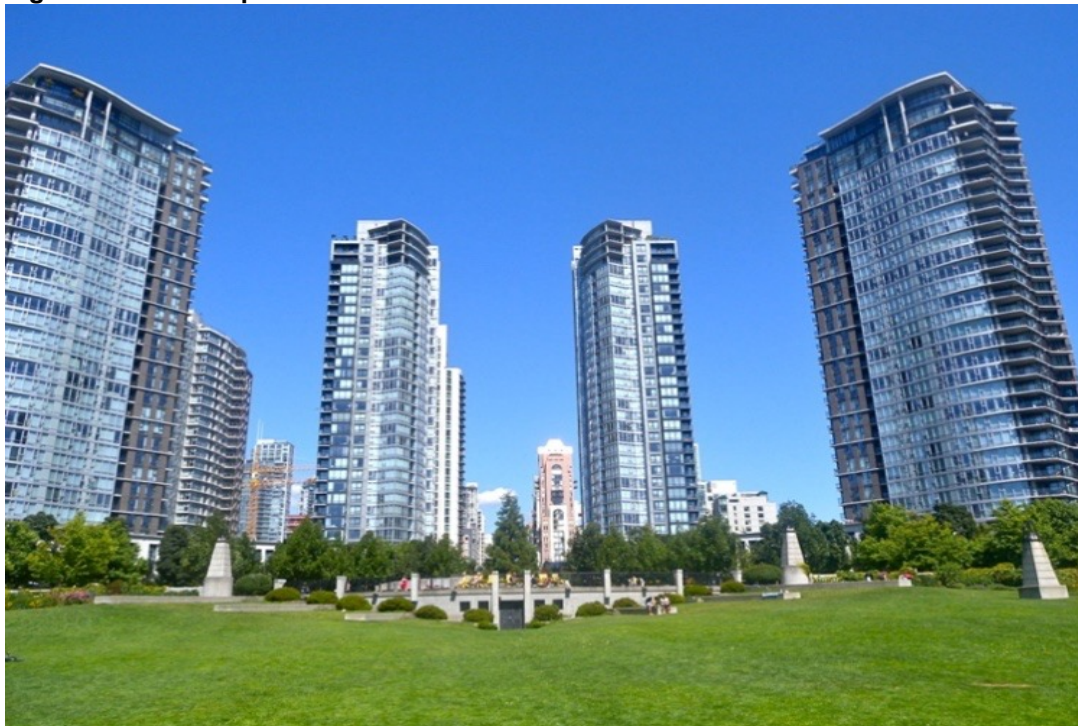
Figure 27 - Le complexe Park West de Concord Pacific à Vancouver
