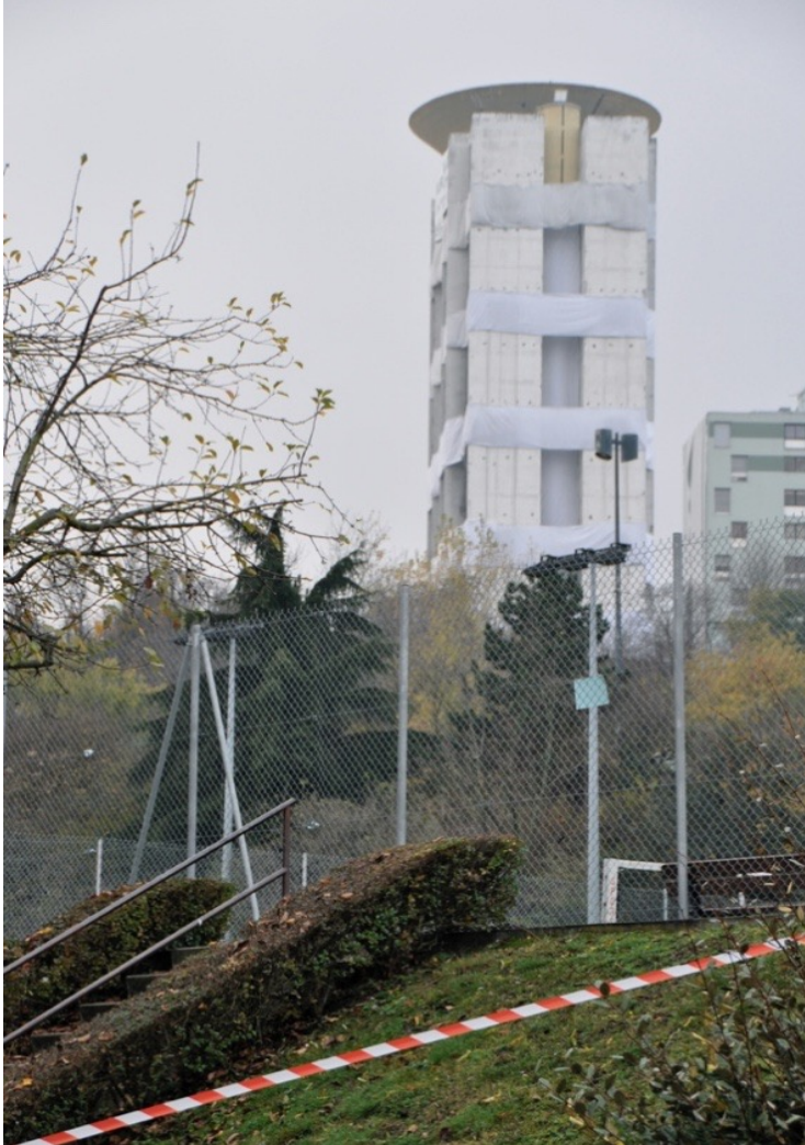
Figure 15 - 24 novembre 2011 : La tour Plein Ciel le jour de sa démolition
