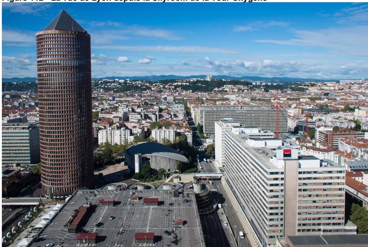
Figure 112 - La vue de Lyon depuis la Skyroom de la Tour Oxygène
