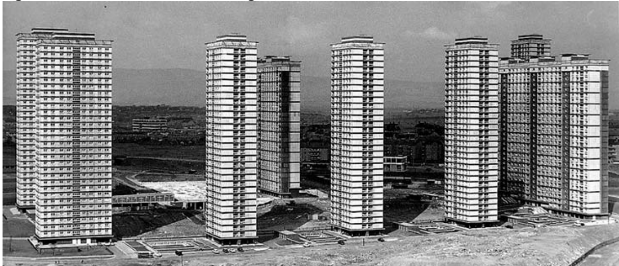
Figure 14 - Le Red Road Estate à Glasgow, livré en 1969
