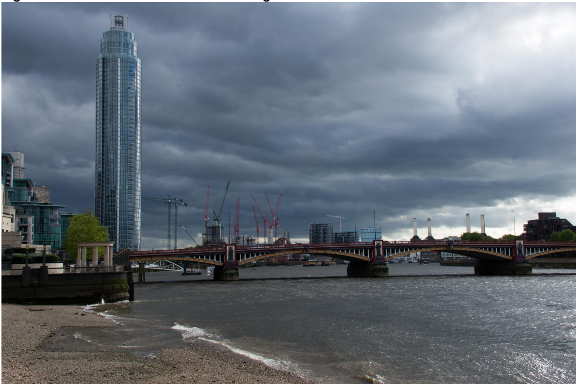
Figure 46 - La tour résidentielle Saint George à Vauxhall
