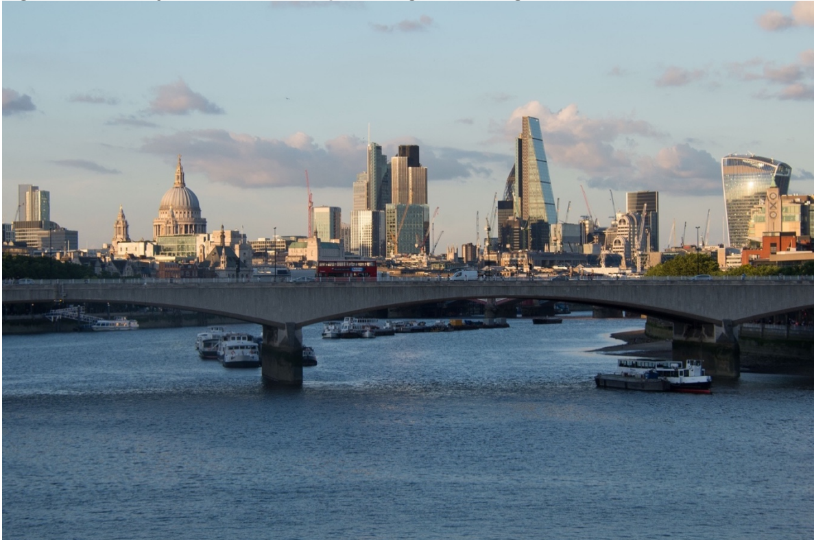
Figure 128 - Le skyline de Londres depuis Hungerford Bridge
