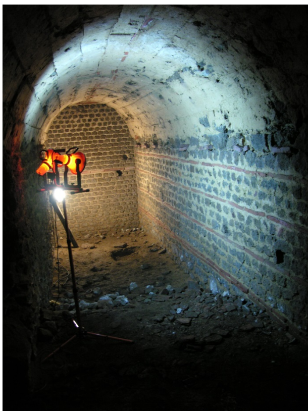
Figure IV-6 : Salle voûtée n°10, rez-de-chaussée des thermes (sous-terrain).
