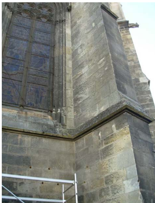
Figure VII-11 : Prélèvements à l'extérieur de la chapelle de la Rose de la basilique Saint Seurin.
