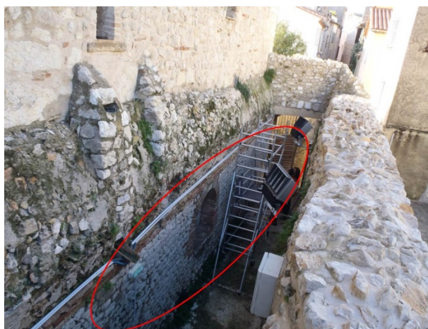
Figure III-5 : Mur des soubassements gallo-romains échantillonné pour la datation par OSL.
