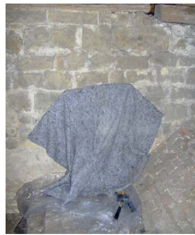
Figure II-3 : Prélèvement par le grattage sous la couverture
