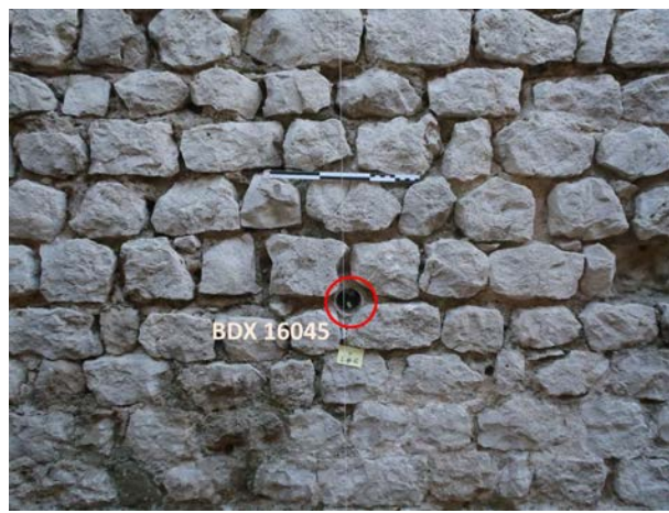
Figure III-8 : Localisation du prélèvement du mortier BDX 16045.
