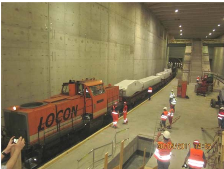
Photo 7 : un des premiers trains dans le city tunnel en construction
