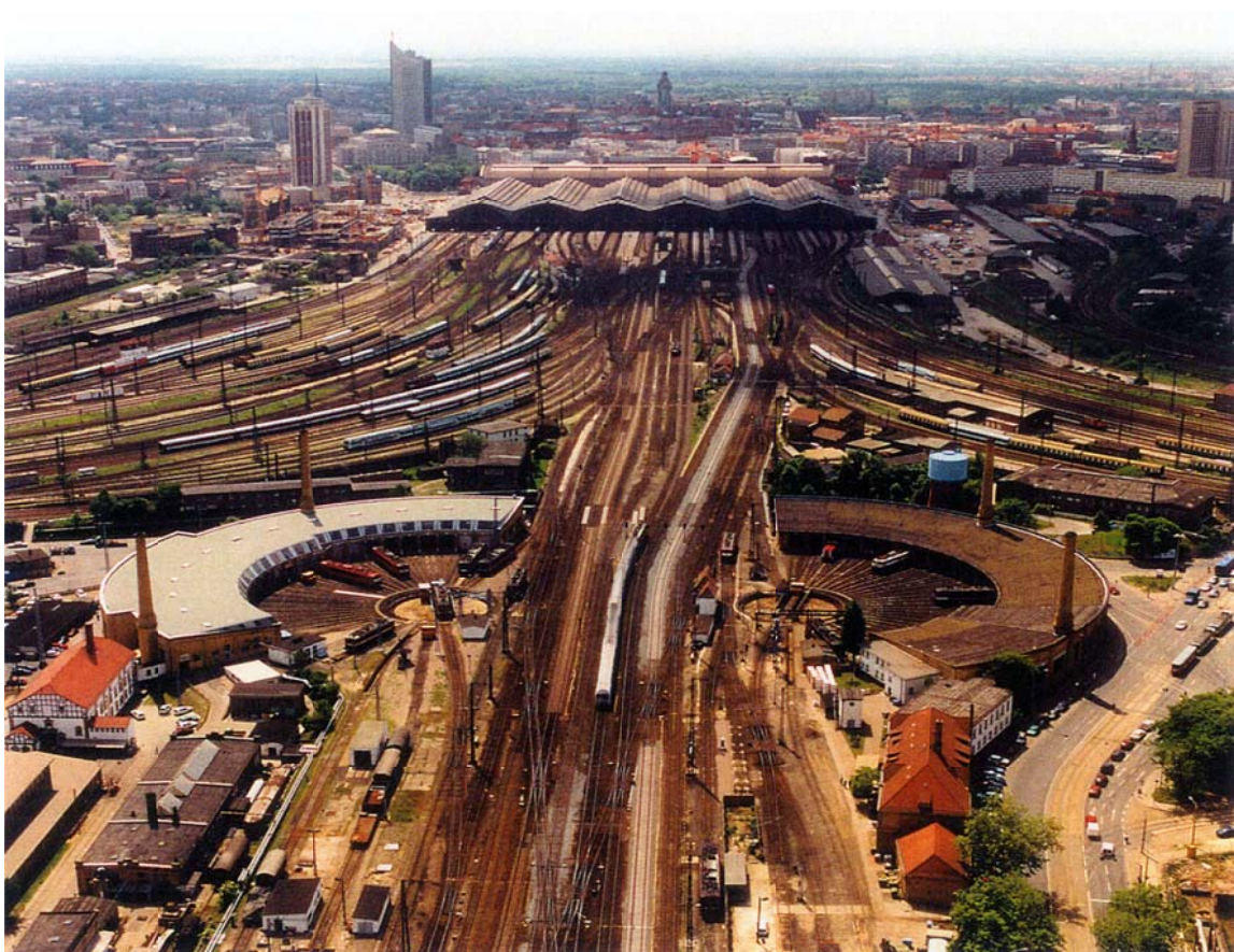
Photo 5 : vue de la gare de Leipzig en arrivant par le nord
