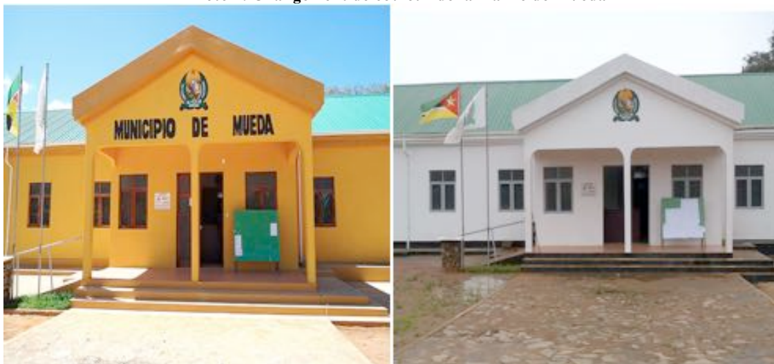
Bâtiment de la municipalité en 2013
