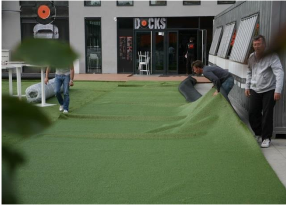
Des salariés d'un restaurant en train d'installer une pelouse synthétique en terrasse.
