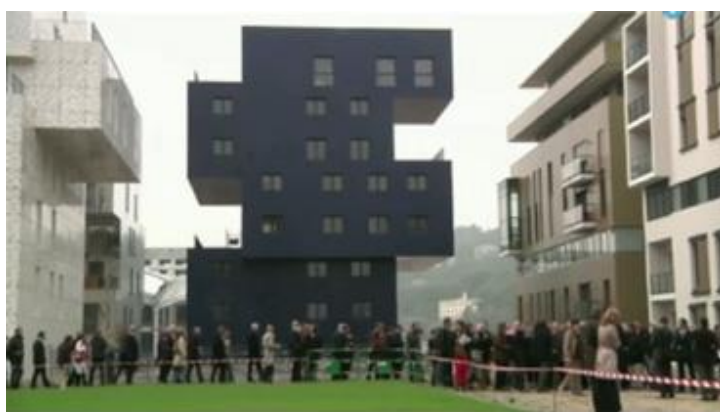
L'immeuble « Sourcea » dessiné par Massimiliano Fuksas (îlot B), lors d'une inauguration. Il fait référence à l'histoire portuaire du site, évoquant une superposition de conteneurs. Photo Communauté urbaine.
