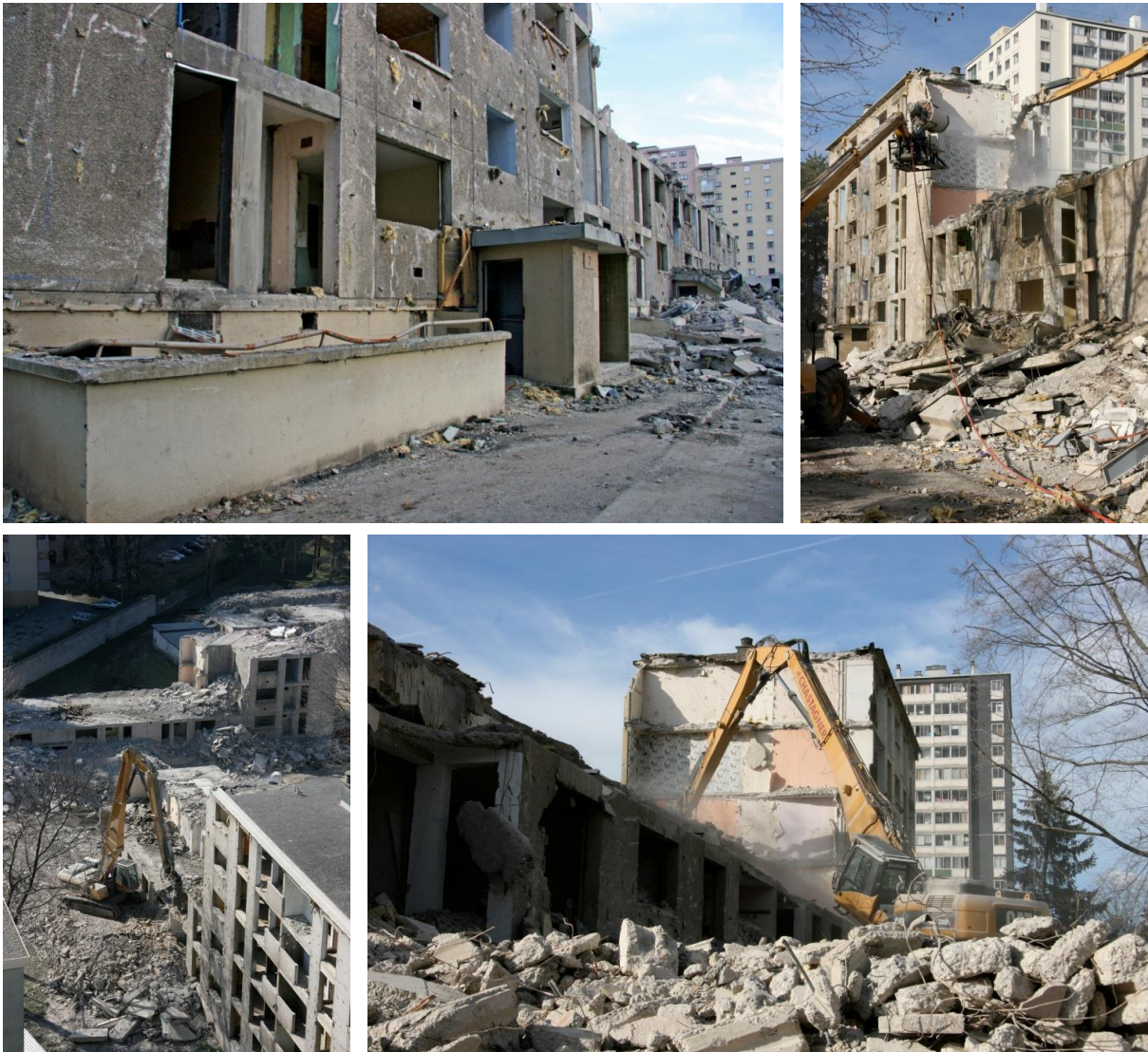
Ambiances autour des chantiers de démolition. Photos Didier Collignon (habitant).
