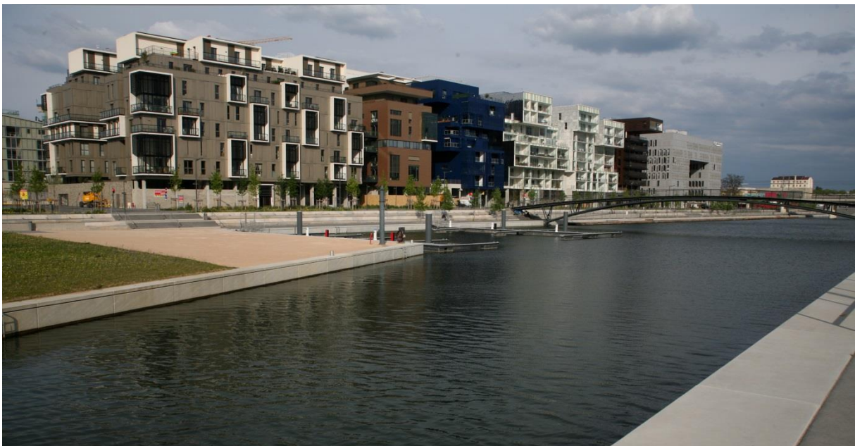
Lyon-Confluence. Vue générale, îlots ABC face à la « Place Nautique ». Photo L. Morand
