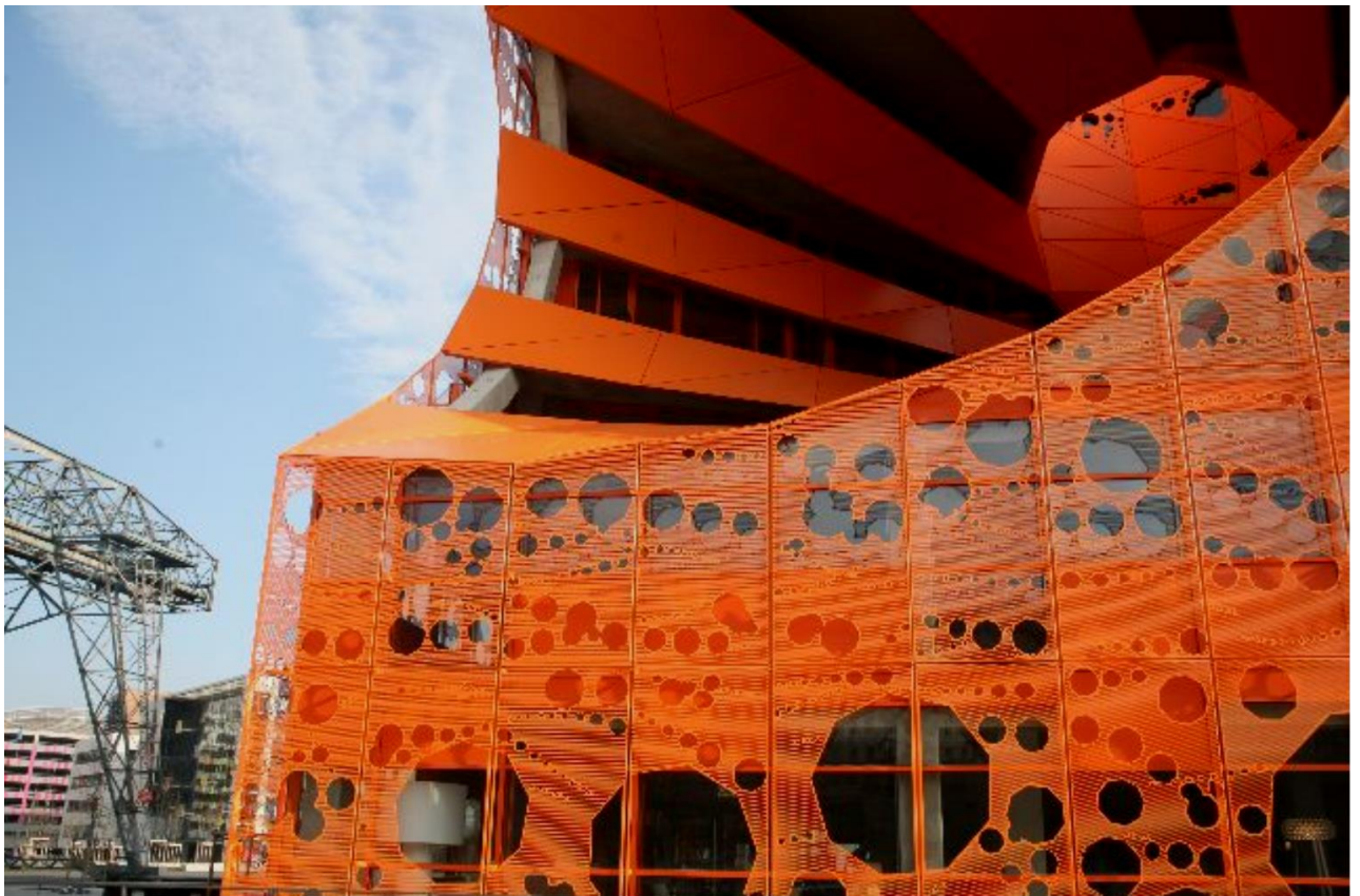
Détails architecturaux. Îlots ABC (en haut) et le « Cube Orange » en bordure de Saône. Lyon Confluence. Photo L. Morand
