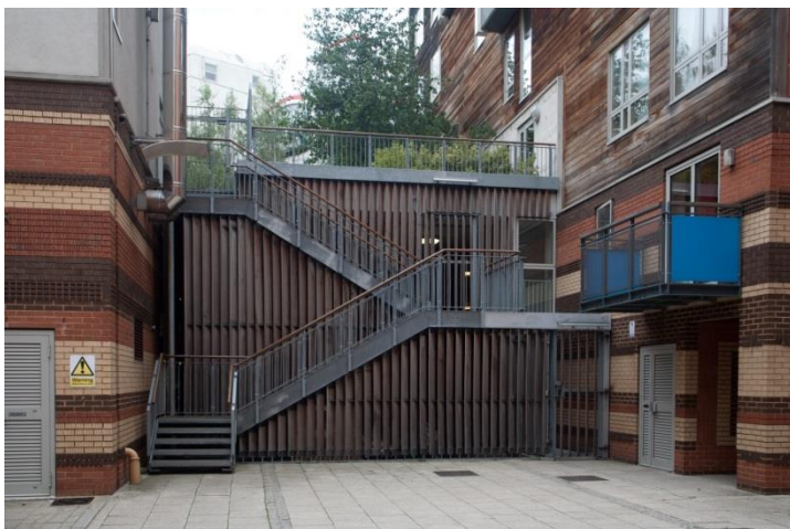
Millennium Village. Accès sécurisé à un cœur d'îlot surélevé par rapport au niveau du sol.
