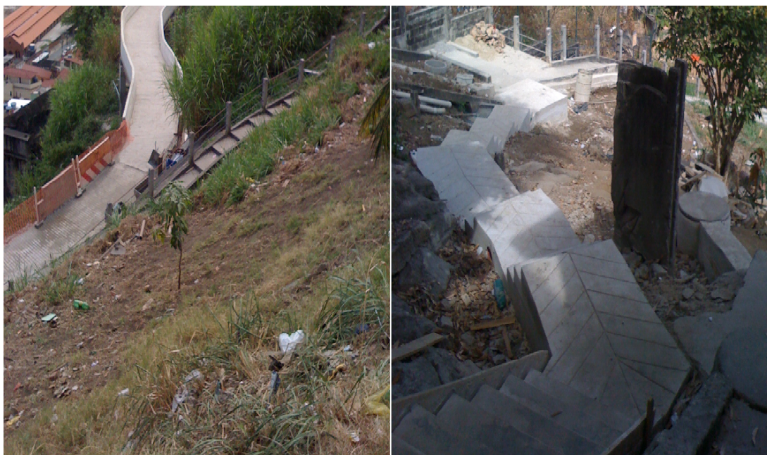
Figure 12 - Infrastructures de mobilité au morro da Providência. "Motovia" en construction (à gauche) et escaliers en construction (à droite) (août 2012)
