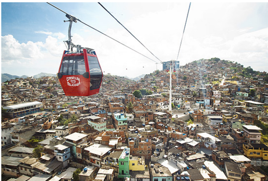
Figure 11 - Le téléphérique surplombant le Complexo do Alemão d'une station à l'autre. Au loin la prochaine station. En bas, une grande majorité des habitants sont localisés à un niveau inférieur aux stations
