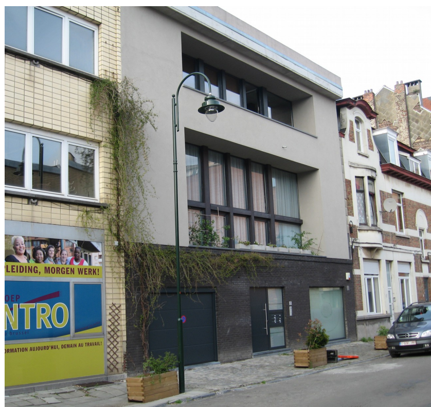
Un immeuble de 4 logements dans le quartier Cureghem – Vétérinaire. Photo François Simillion.
