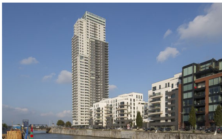
Le projet « Up-Site », 252 appartements. Source : www.atenor.be .
