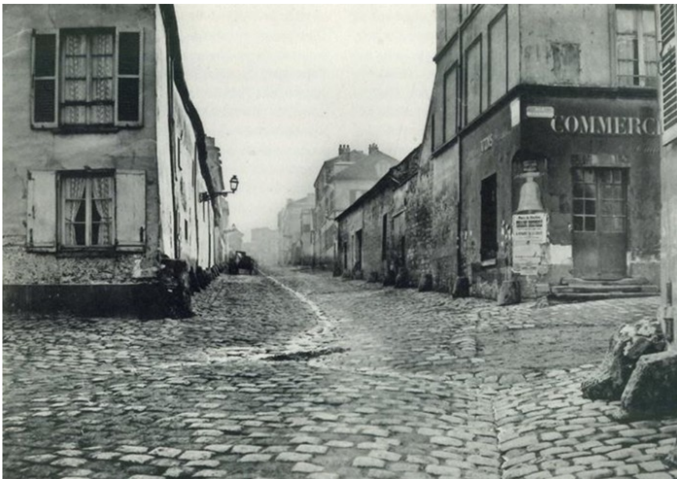
ANNEXE 91. Bornes ou « chasse-roues » destinées à protéger les murs et piédroits des portes à Paris en 1867 (photo : Charles Marville)
