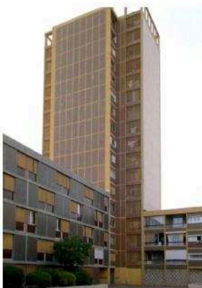
Façade d'une tour à l'angle des barres.
