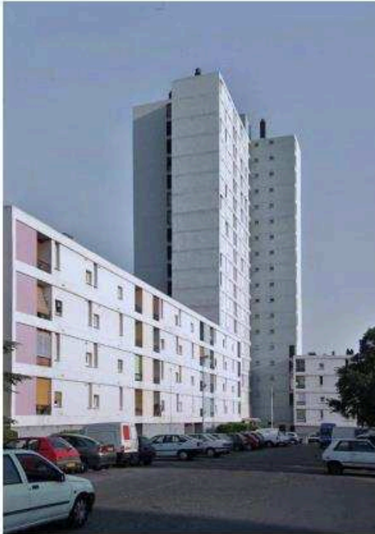
Vue sur la tour et son accroché en « manivelle » à la barre.
