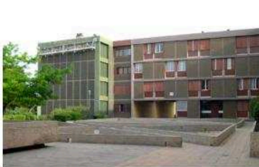
Façade sur les séjours d'une barre.
