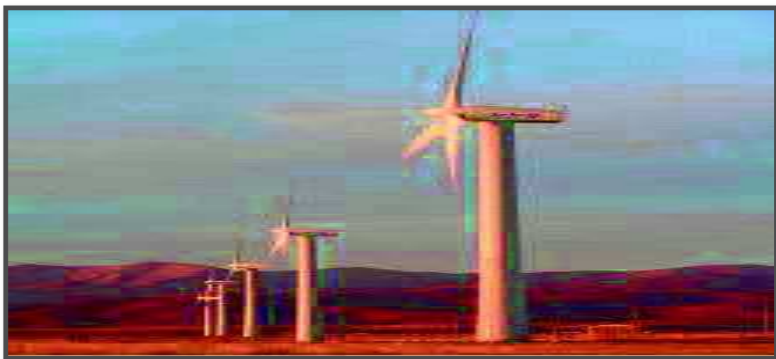
Photo 32; l'énergie éolien : Source: 'institut des nouveaux d'énergie-site internet
