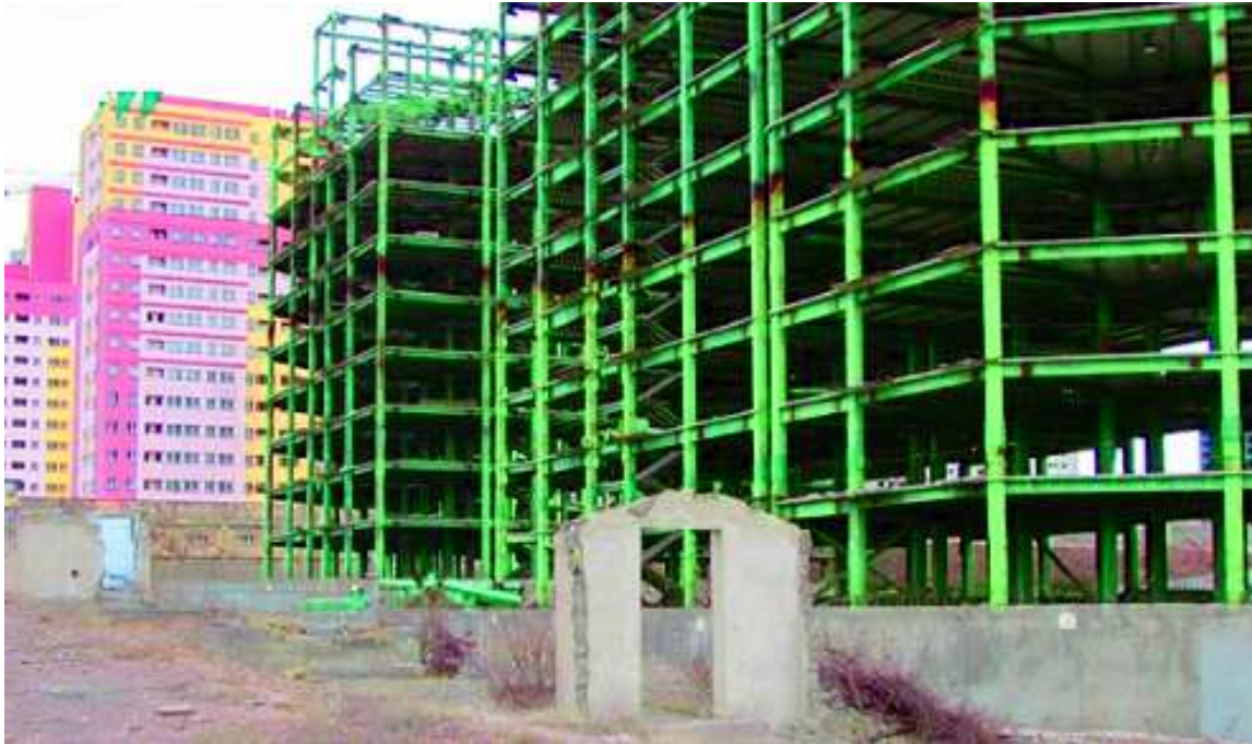
Photo 40 ;Construction à l'entrée de la ville de Hashtgerd ; Source : memarines.com
