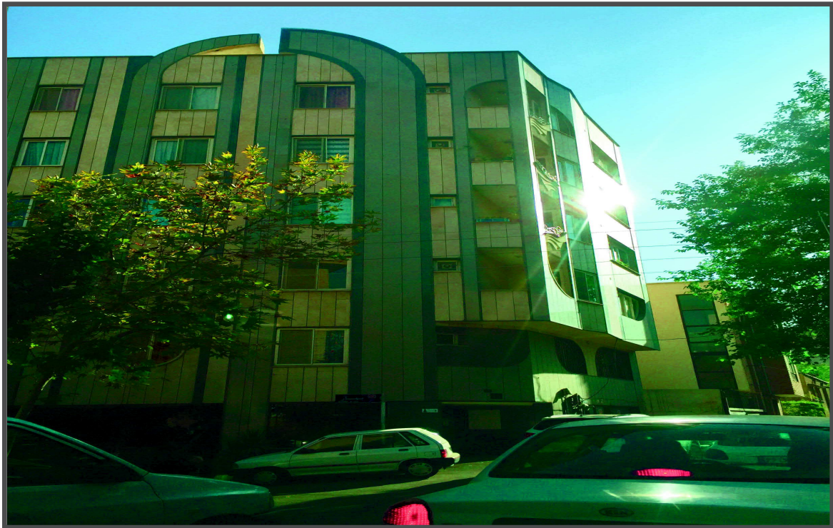
Photo 29-30 : Matériaux récents de construction ; photo : AZARI2014
