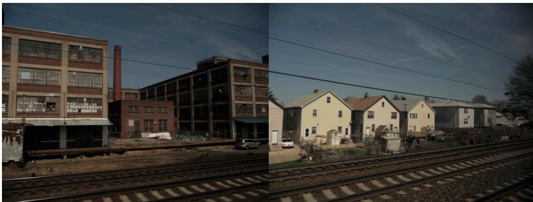
Illustration I.2.3 – La densité du corridor ferroviaire Nord-Est entre Washington D.C. et New York
