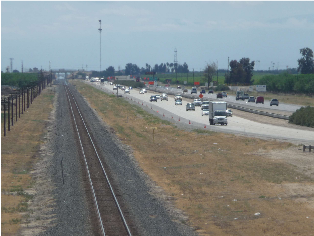
Illustration II.3.4 – La voie ferroviaire de la BNSF et l'autoroute 99 au Nord de Bakersfield
