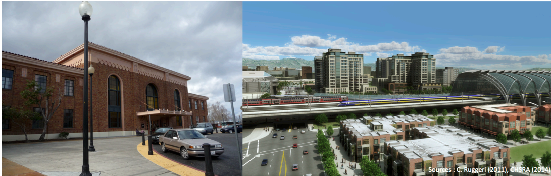
Illustration IV.8.7 – L'actuelle gare de San Jose Diridon (gauche) et le projet de l'Autorité (droite)
