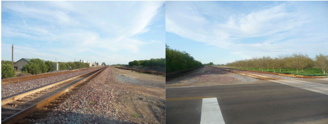
Illustration III.6.1 – La voie de la BNSF à l’est d’Hanford
