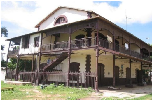
Photo 27 : La gare de Tivaouane
