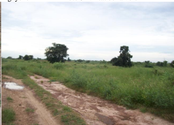
Photo 34 : Etat de la voie
