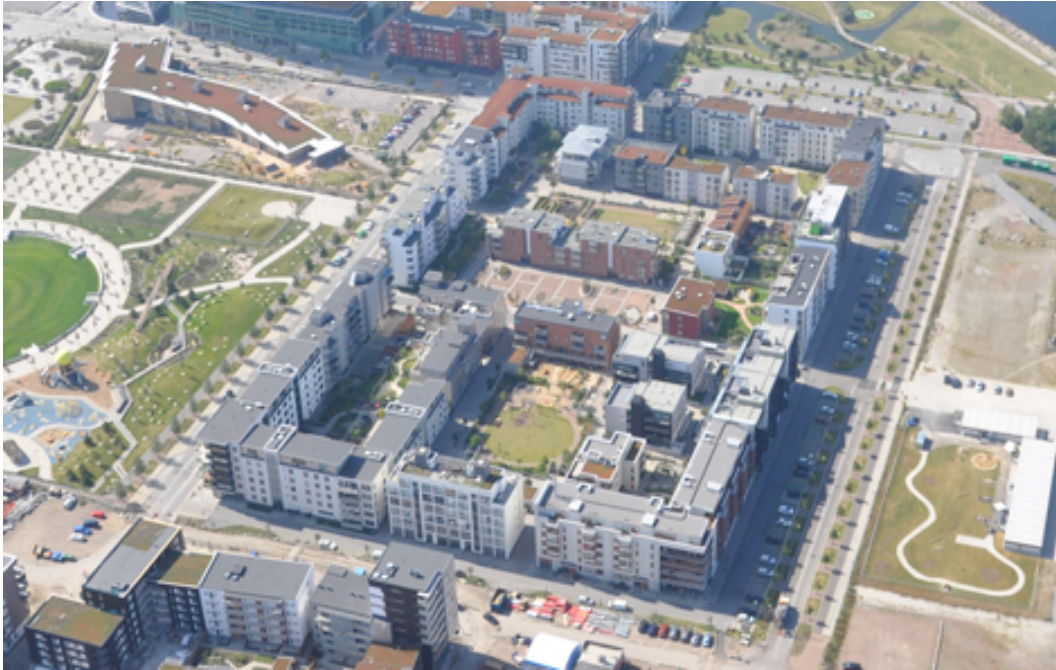
Figure 11. Vue aérienne du projet Flagghusen
