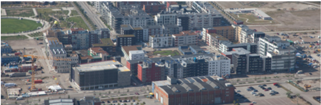
Figure 12. Vue aérienne du projet Fullriggaren
