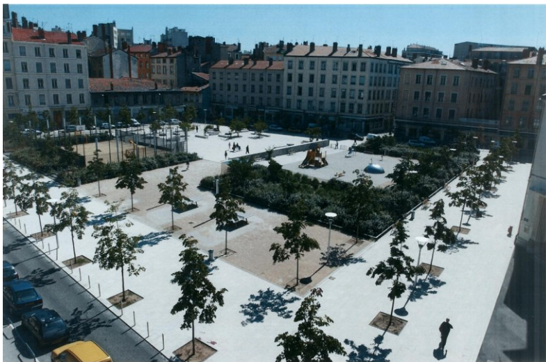
Figure 22- Vue d'ensemble de la place Bahadourian aménagée
