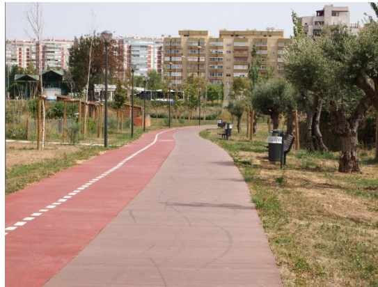
Figure 71- Les pistes cyclable et piétonnière, longées par des bancs et poubelles et, à gauche, les plots horticoles (Quinta da Granja)
