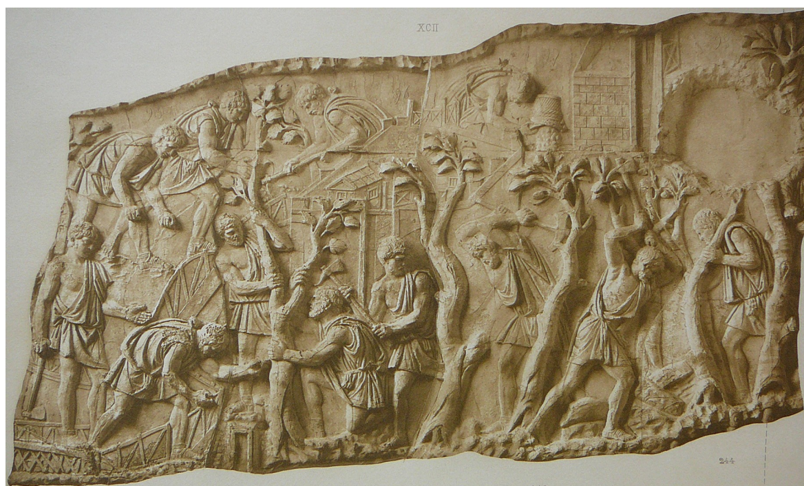
Figure 17 : Travaux effectués par des classarii (Rome, colonne Trajane scène XCII)
