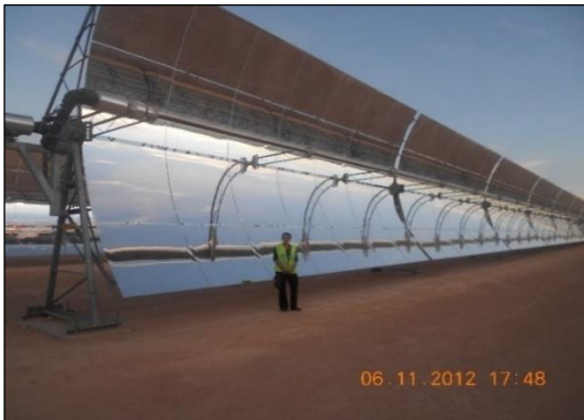
Photos 7-8 – Structure cylindro-parabolique de la centrale hybride solaire-gaz de Hassi R'mel en Algérie
