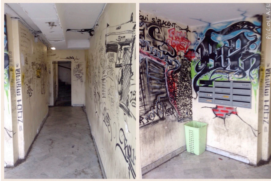
Photos 8 et 9 : La Forestière, halls d'entrée. (Rémi Habouzit, décembre 2012).
