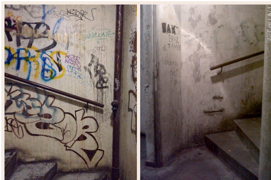
Photo 10 et 11 : La Forestière, escaliers. (Rémi Habouzit, avril 2013).
