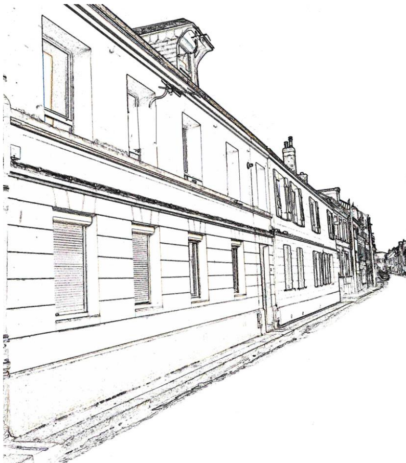
Figure 21 : Ancienne école et pensionnat des sœurs de la Providence rue de Mer.
