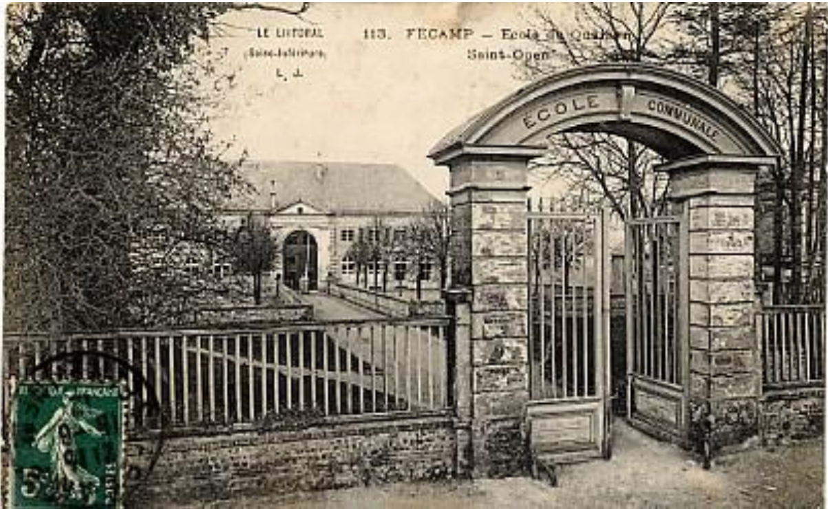
Figure 86 : École du quartier Saint-Ouen.
