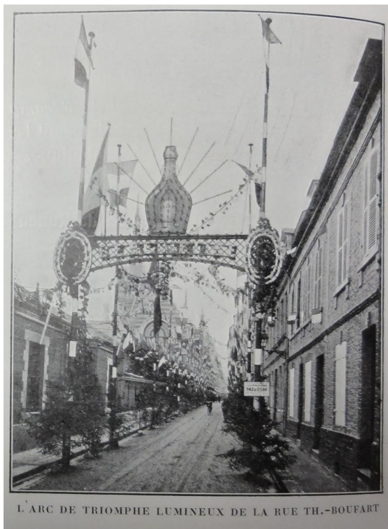
Figure 103 : Arc de triomphe lumineux de la rue Théagène-Boufart.
