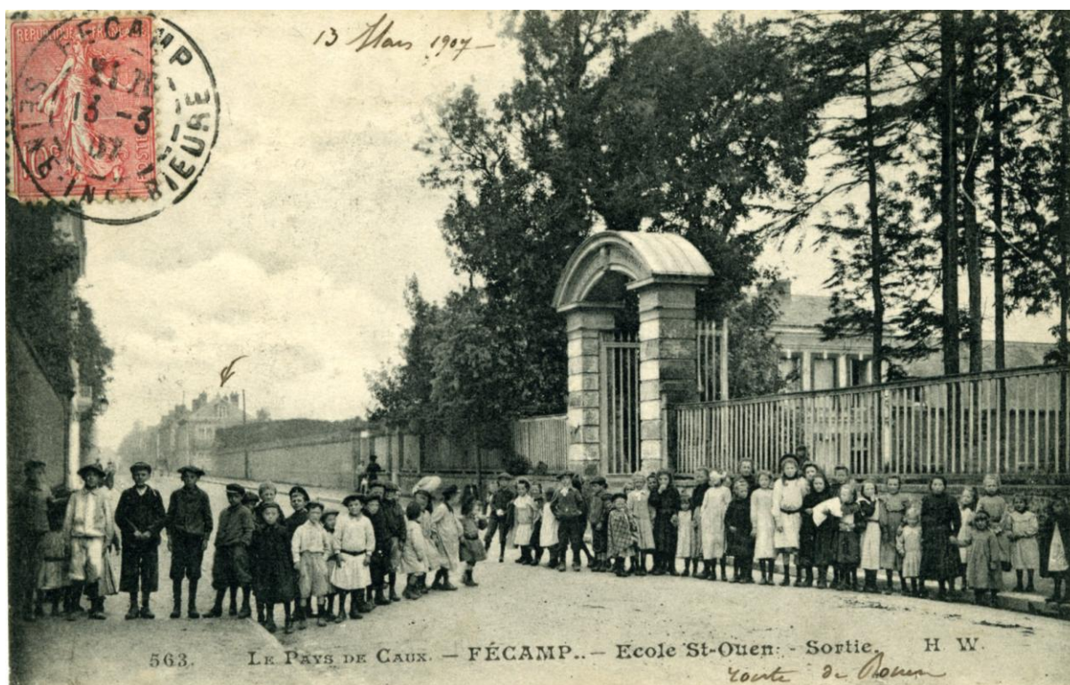
Figure 85 : École du quartier Saint-Ouen.
