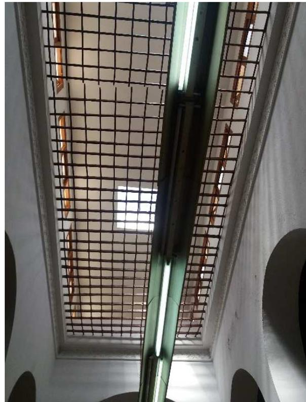
Figure VIII-34 : Photo de la couverture du patio montrant le grillage existant et les fenêtres hautes créées en dessus
