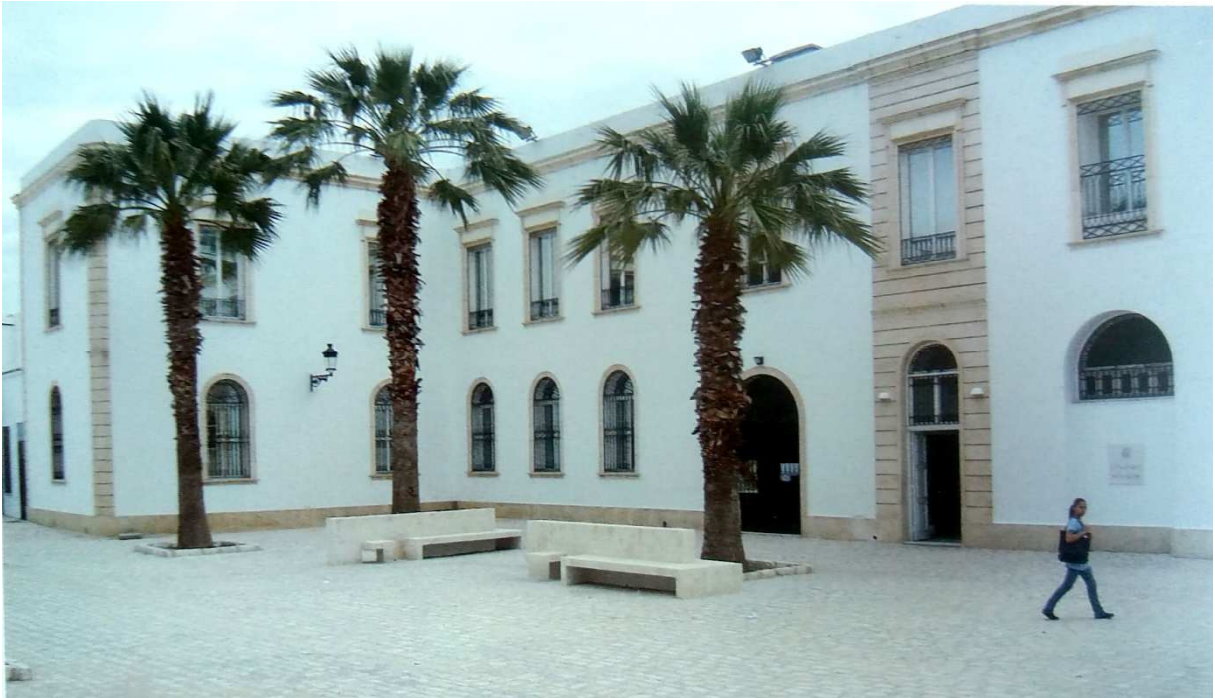
Figure IV-33 : façades du palais donnant sur la place du tribunal (après restauration et réaffectation) (Akrouit Yaïche (dir), 1998)
