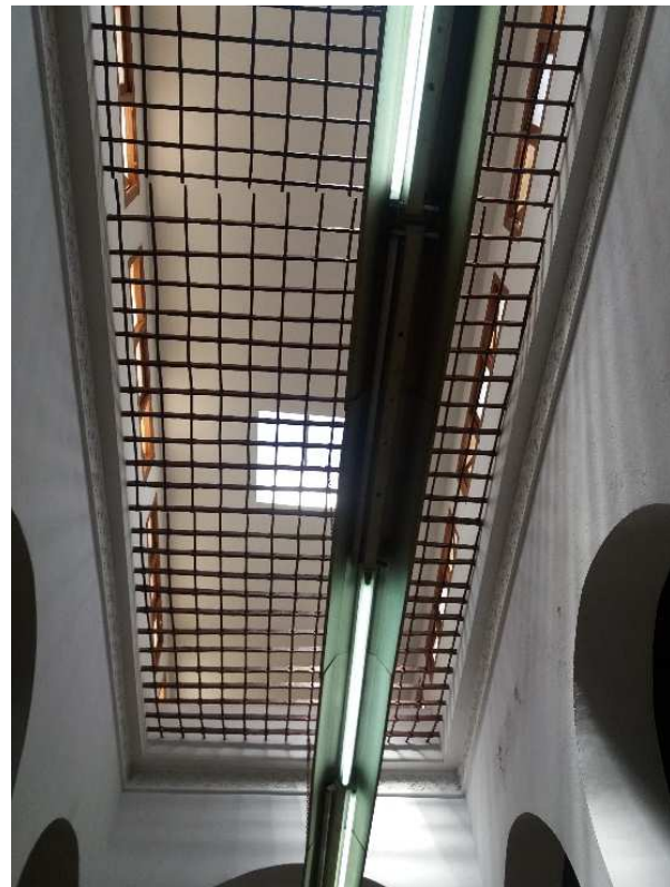
Figure VIII-34 : Photo de la couverture du patio montrant le grillage existant et les fenêtres hautes créées en dessus
