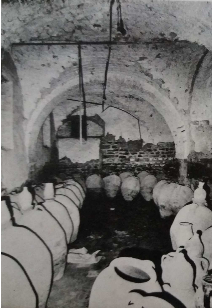
Figure IV-34 : Vue intérieure du Makhzen avant les travaux de restauration (Heinz, 1972)
