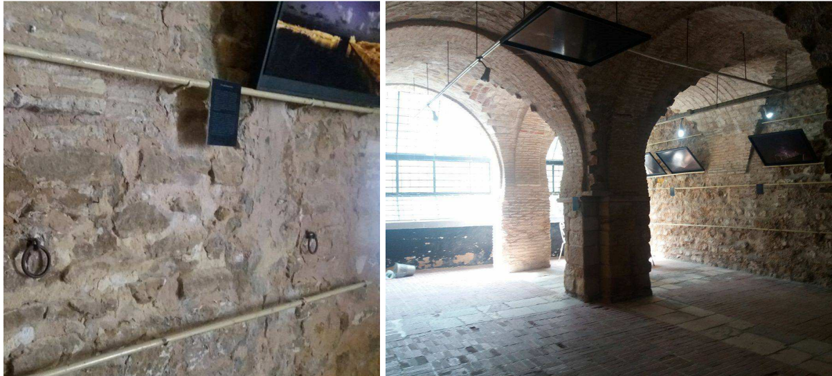
Figure VII-3 (à gauche) : Anneaux ayant servi autrefois pour attacher les chevaux dans l'écurie, actuelle salle d'exposition du CCTH Figure VII-4 (à droite) : Ancienne écurie réaménagée en salle d'exposition, avec révision des systèmes d'éclairage naturel et artificiel
