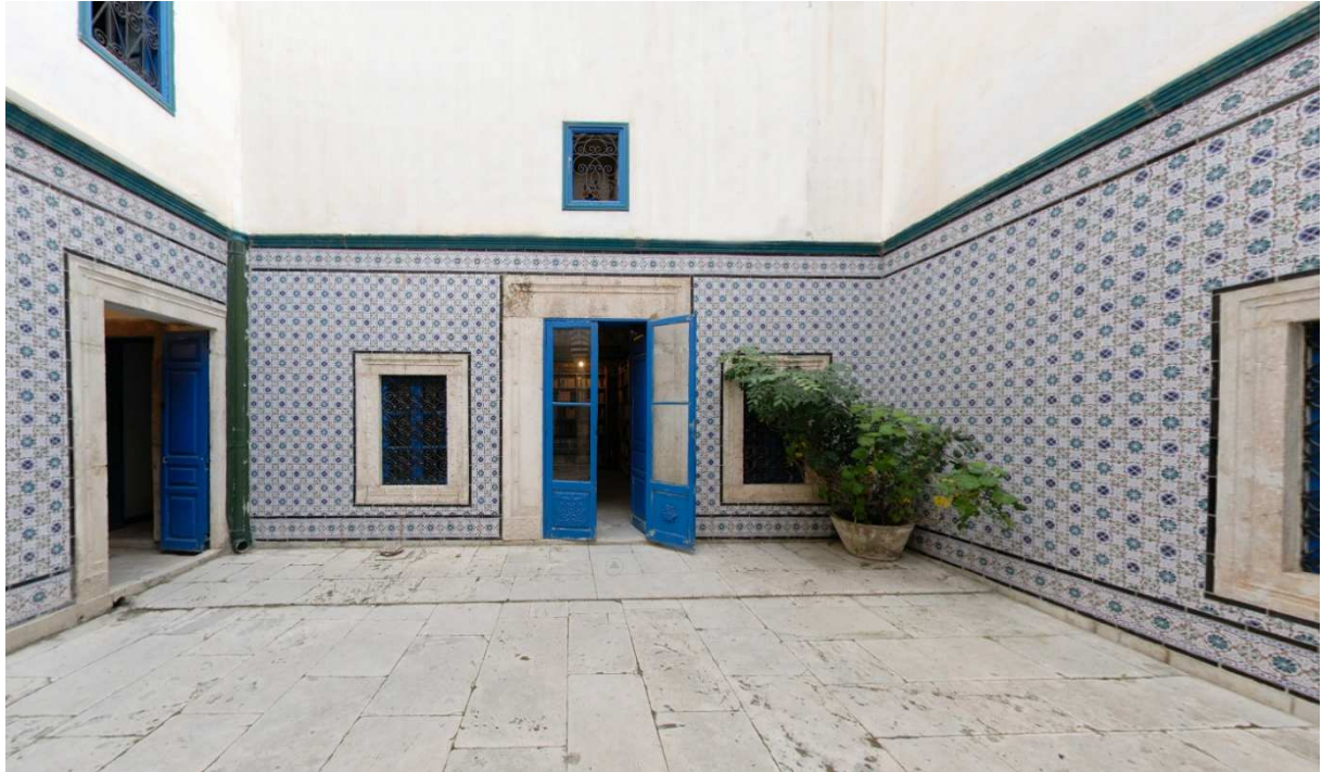
Figure IV-15 : Patio du Dar Ben Achour (façade de la chambre orientée Nord avec traces de l'ancien portique au sol)
