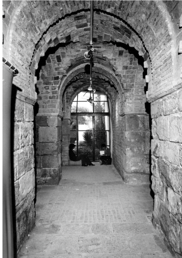
Après restauration pieds droits consolidés, création de porte-fenêtres, revêtement de sol refait, éclairage par spots sur rail
