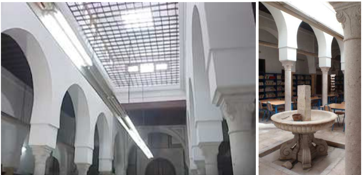
Figure IV-49 : A gauche : Détail de l'éclairage zénithal du patio
