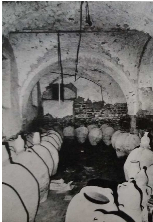
Figure VII-1: Photo prise avant les travaux de reconversion montrant les jarres utilisées pour stocker les provisions dans le Makhzen de Dar Lasram (Source ASM)
