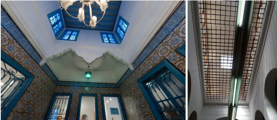
Figure VIII-1 : (à gauche) : Dispositif « raqba » avec fenêtres hautes latérales pour l'éclairage du patio couvert de Dar Bouderbala – actuelle galerie de la médina.
