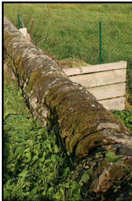
Mur de pierres sèches bâti en grès et en calcaire à Dompaire Le couronnement de ce mur est constitué de demi-cylindres de grès
