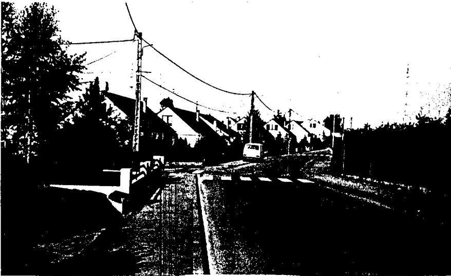
Ensemble de "chalandonnettes" construites par la société S.I.M.L.O.R. à Marly.
