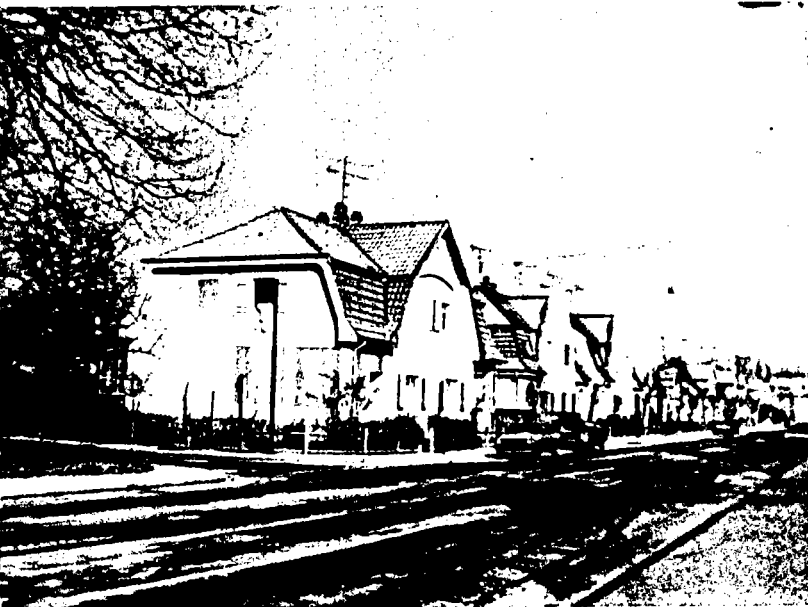
Cité ouvrière à Hagondange construite durant l'annexion allemande.
