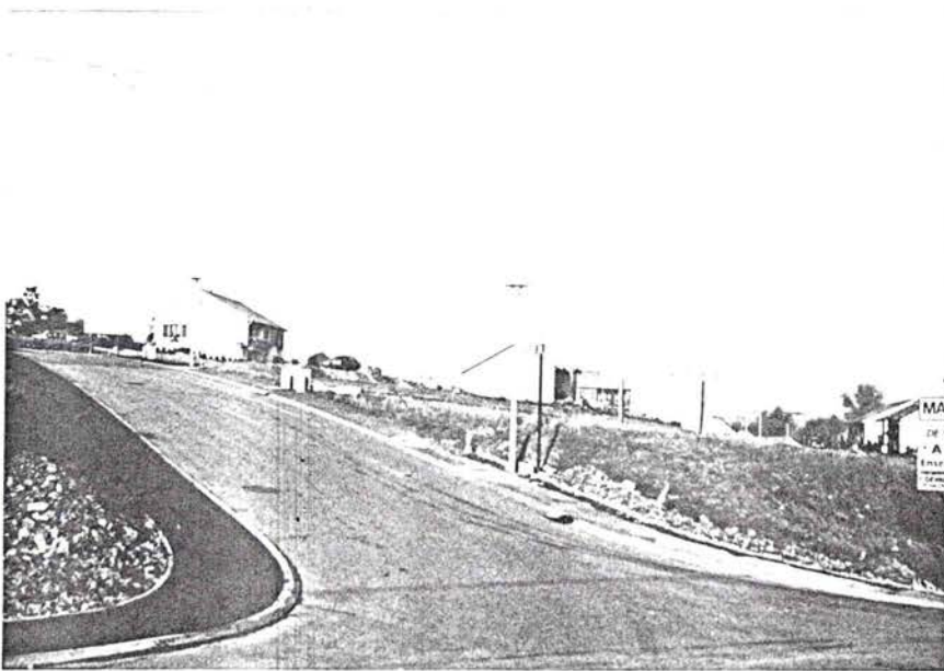
Lotissement "Les Coteaux du Soleil" à Saint-Julien en construction actuellement.
