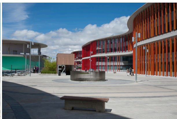
Pavillons de l'Exposition : à droite de l'image, pavillons réhabilitées en attente d'affectation, à gauche, pavillons en travaux.
