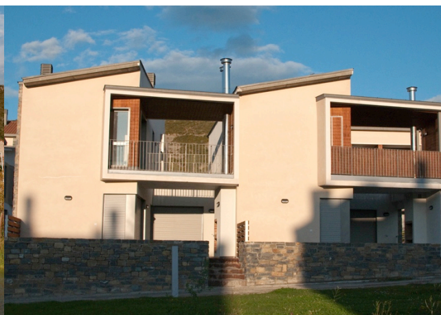
Maisons individuelles mitoyennes avec façades extérieures et murs de séparation entre espaces collectifs et espaces privés en pierre, dans un souci d'évoquer l'architecture traditionnelle. Sept. 2009
