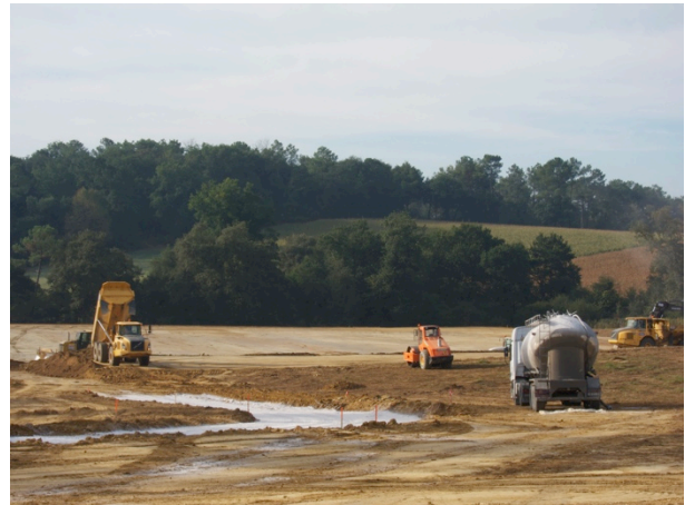
Site du second forage d'exploration d'EDF, en cours de nivellement, ancienne parcelle de m ais non irriguée, louée à un agriculteur pour 4 ans avec option d'achat au terme du bail.
