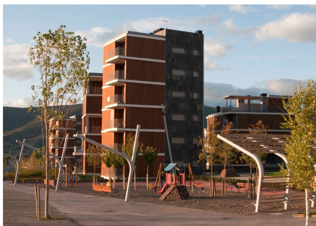
Immeubles collectifs à 5 étages avec parements en bois ou en pierre « du pays » pour les façades. Au premier plan, une aire de jeux végétalisée. Sept. 2009
