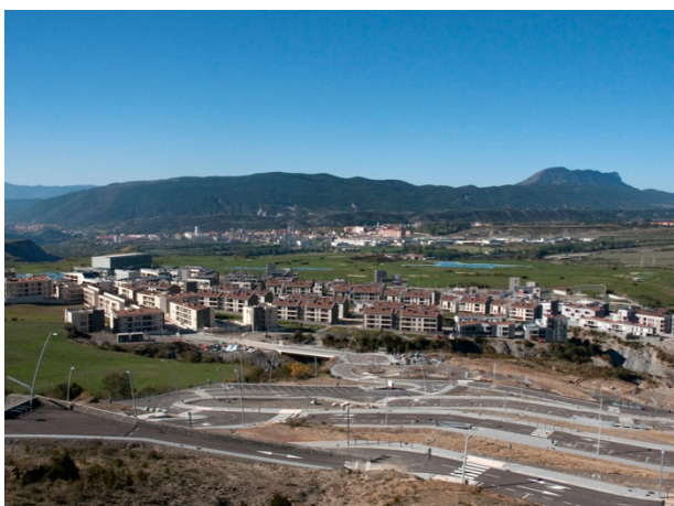
Vue générale : au premier plan, une zone viabilisée en attente d'urbanisation, à l'arrière-plan, la phase réalisée, le parcours de golf, la ville de Sabiñánigo puis les Sierras extérieures. Oct. 2009
