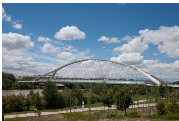
Promenade en bordure de l'Èbre et au centre de l'image : pont du troisième millénaire, pont routier enjambant l'Èbre doté d'un arc en béton suspendu de 40 m de haut. Sur le côté on devine, une voie vitrée réservée aux piétons.
