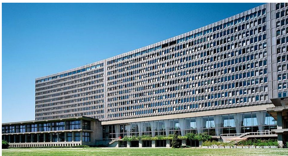
Figure 30 : le bâtiment central de l'OIT (Genève, 2012)
