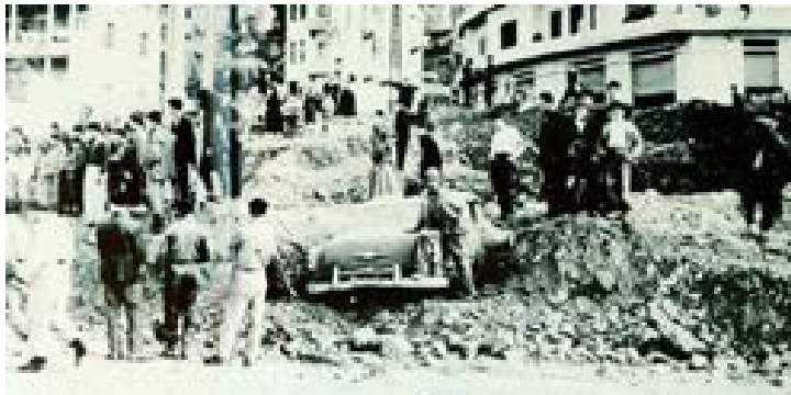
Entrée est du quartier de Zahriyé obstruée de matériaux emportés par la crue du 17 décembre 1955. Source : collection de l'auteur.
