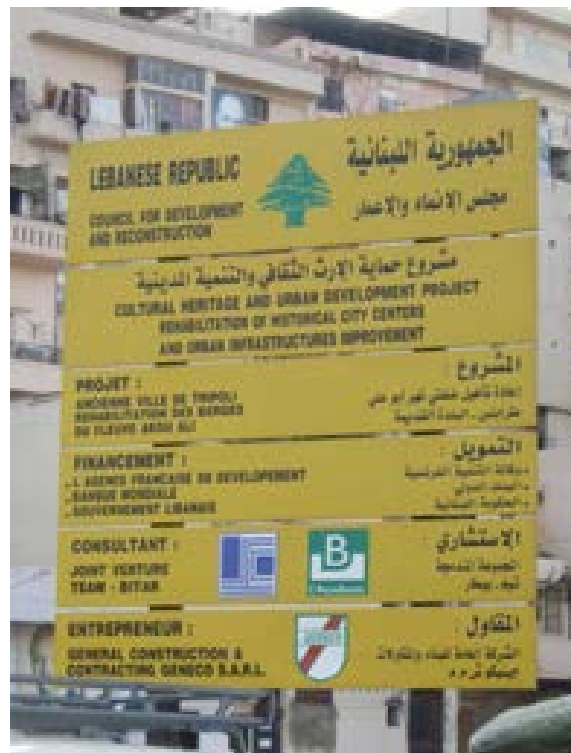
Panneau du chantier de la réhabilitation des du fleuve Abou Ali (Pas de durée annoncée - CHUD)
