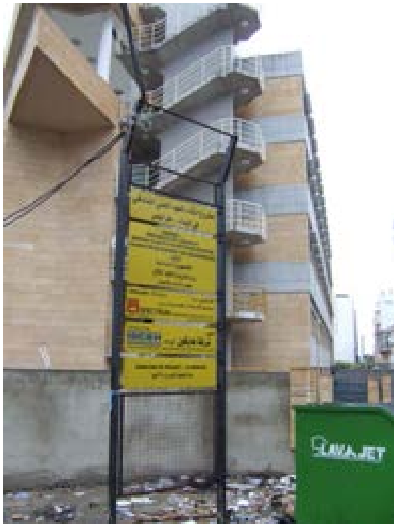
Panneau du chantier de l'école hôtelière publique à Al-Mina (durée des travaux 24 mois - hors CHUD).
