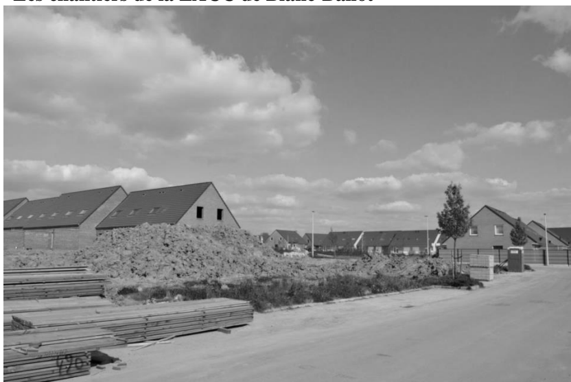
Figure n°45. Les chantiers de la ZACC de Blanc-Ballot
