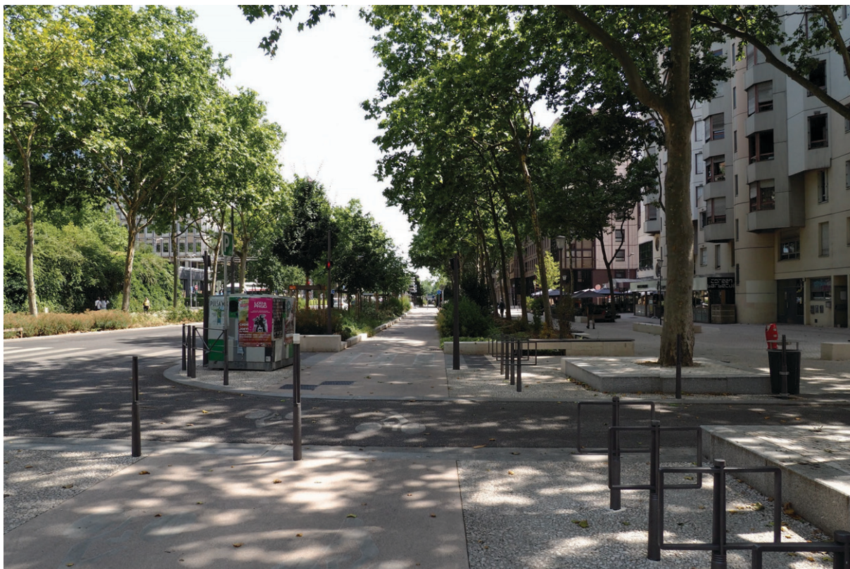
Figure 196 : Le nouvel aménagement de la rue Garibaldi offre des espaces dont l'agrément thermique en période de fortes chaleurs n'est plus seulement assuré par l'ombrage offert par les bâtiments mais aussi désormais par la forte présence végétale autour de l'axe (cliché : Benoit Romeyer).
