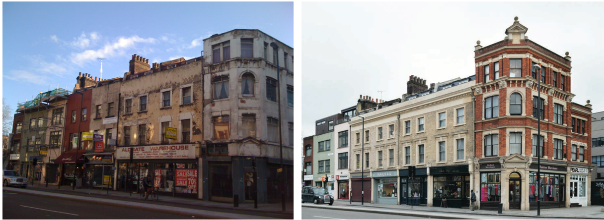
Figure 212 : Illustrations des transformations parfois assez spectaculaires opérées dans le cadre de l'Historic Buildings Conservation Scheme développé pour High Street 2012 (ici au niveau d'Aldgate) et dont l'objectif a consisté à redonner un aspect plus « authentique » à certains immeubles présents le long de l'axe tout en n'obérant pas leur capacité à répondre aux besoins actuels, en particulier en matière d'occupation commerciale (clichés donnés par l'interlocuteur rencontré lors de l'entretien BR n°1, cf. Tableau 7 ; auteur inconnu).
